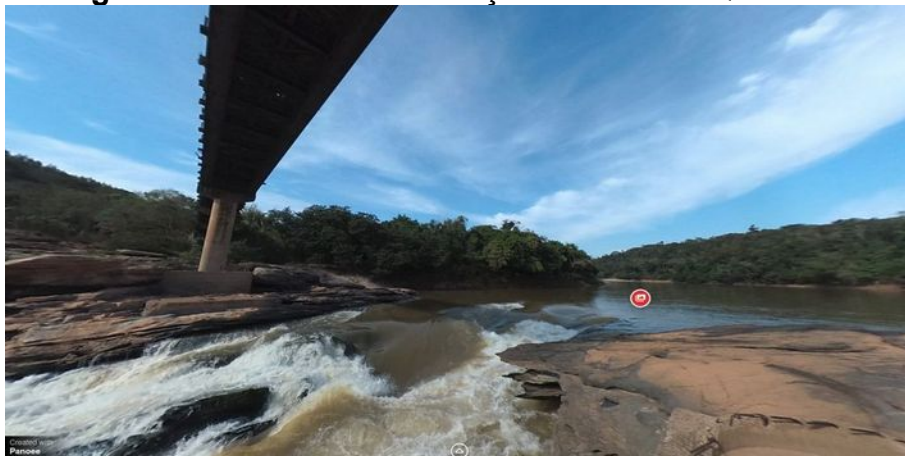
Figura 90 - Ponto de observação 2 da Ponte Queimada
