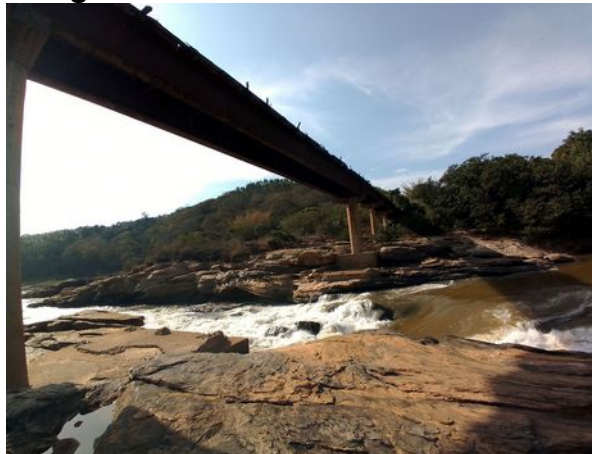
Figura 11 - Foto da Ponte Queimada
