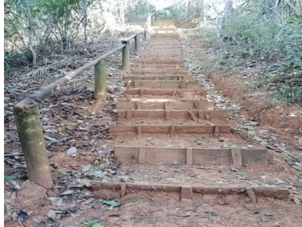
Figura 37 - Escada de acesso à entrada e saída da trilha
