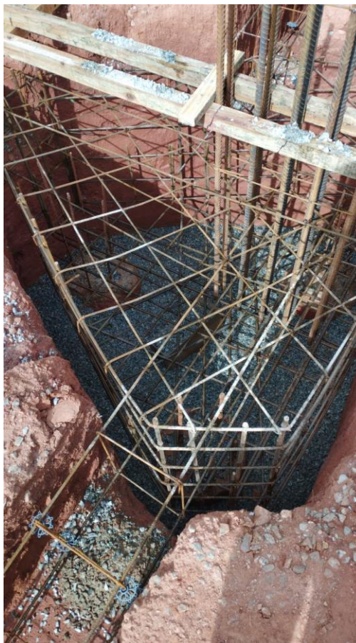
Figura 27 - Bloco de coroamento
