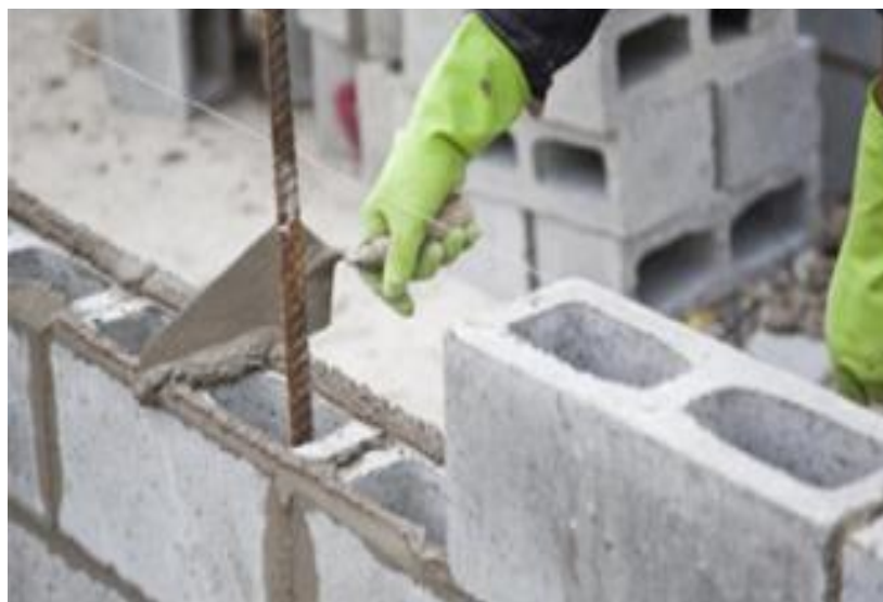
Figura 3 - Argamassa de assentamento
