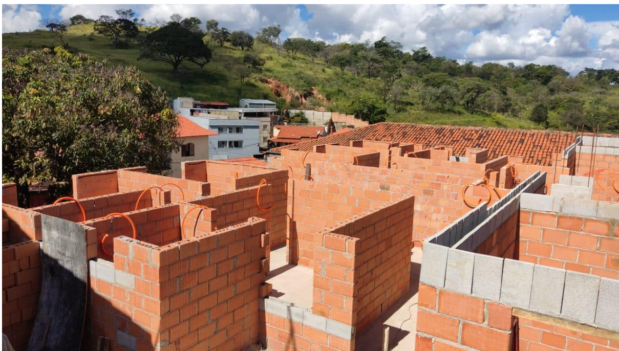
Figura 31 - Execução alvenaria
