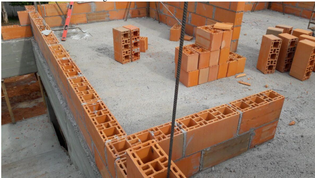
Figura 2. Alvenaria estrutural cerâmica
