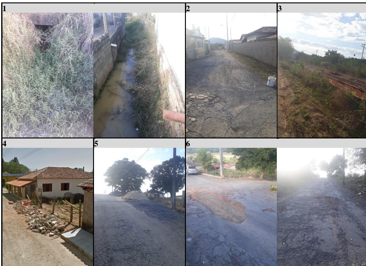
Figura 11 – Registro fotográfico dos parâmetros de problemas ambientais notórios de Tapiraí-MG
