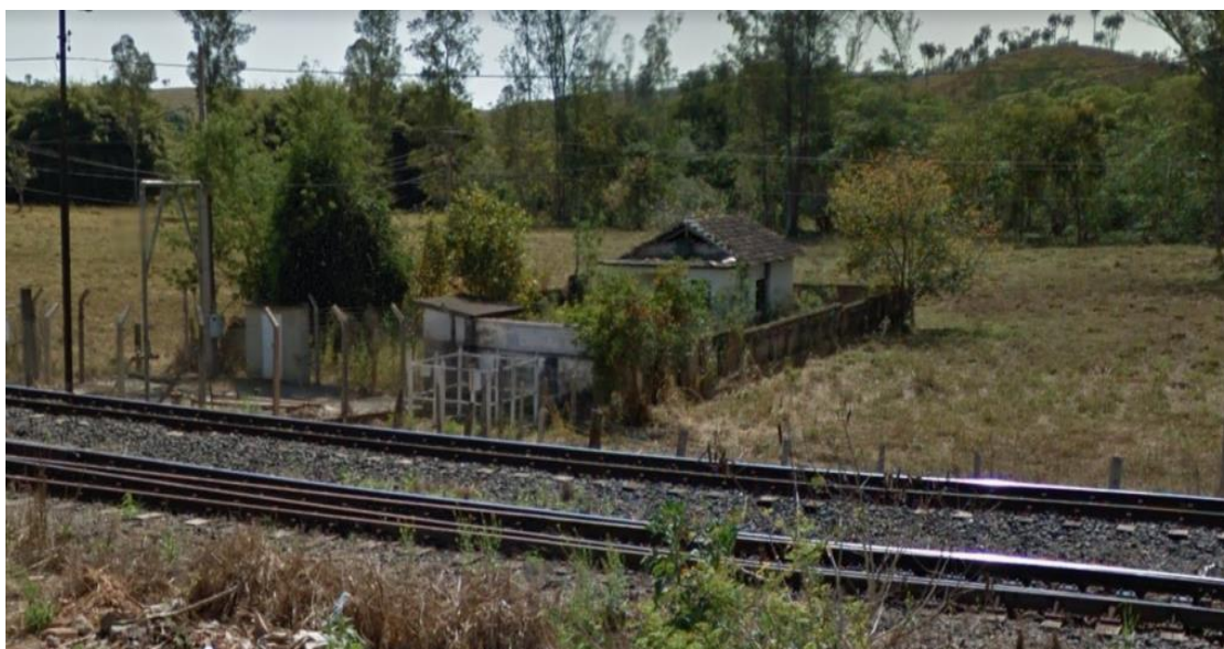
Figura 17 – Localização do poço artesiano e do reservatório de água da COPASA em Tapiraí-MG
