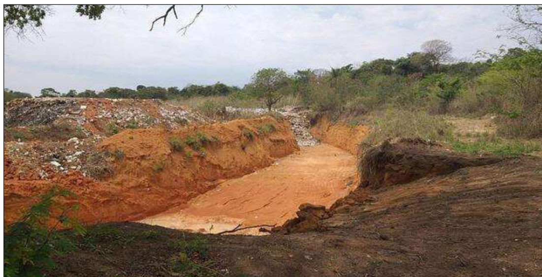
Figura 3 – Vala aberta para aterramento dos RS
