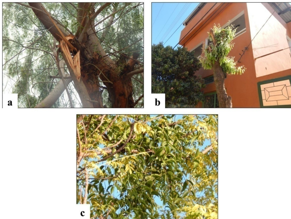
Figura 14 – Problemas relacionados aos galhos da arborização urbana de Bambuí – MG. Galhos secos e quebrados (a); brotações epicórmicas (b) e erva-de-passarinho (c)
