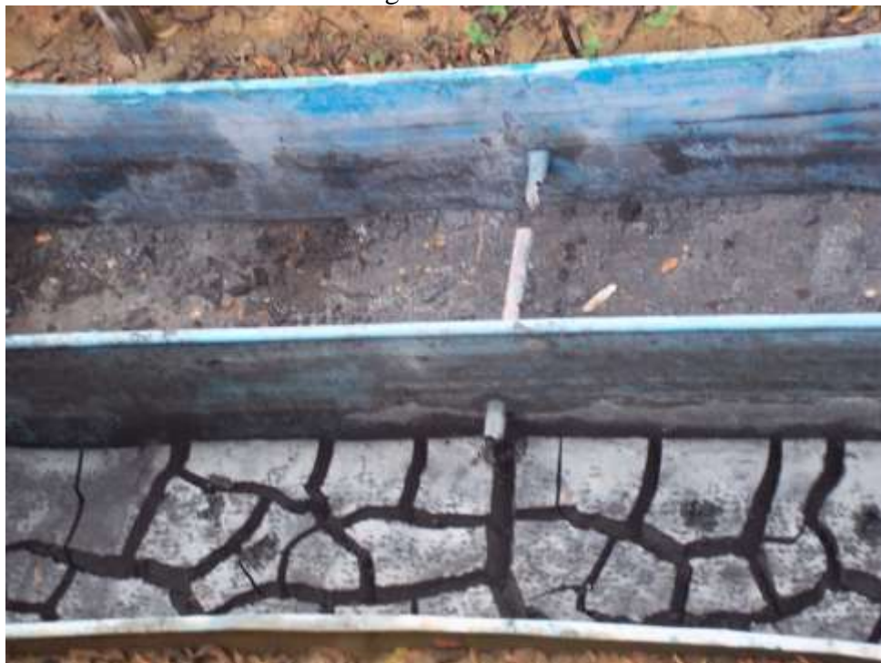
Figura 1 – Leito de secagem do lodo provindo do tratamento de águas residuárias industriais de fogos de artifícios
