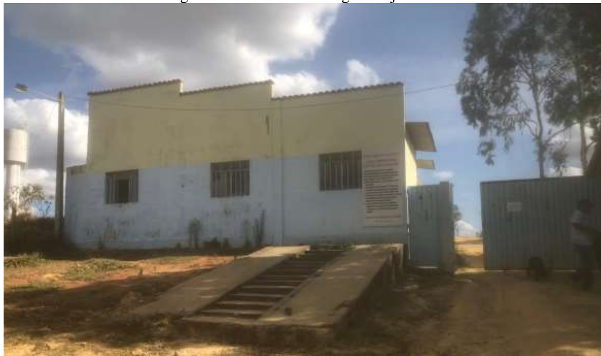
Figura 3 – Fachada da “Fogos Beija-Flor”
