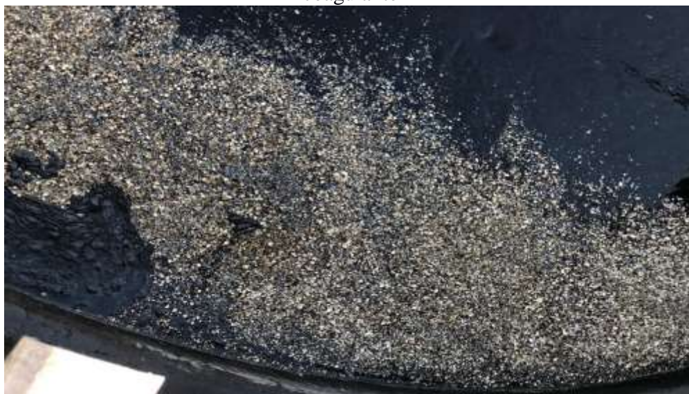
Figura 12 – Caixa de floculação do tratamento de águas residuárias industriais com adição de coagulante
