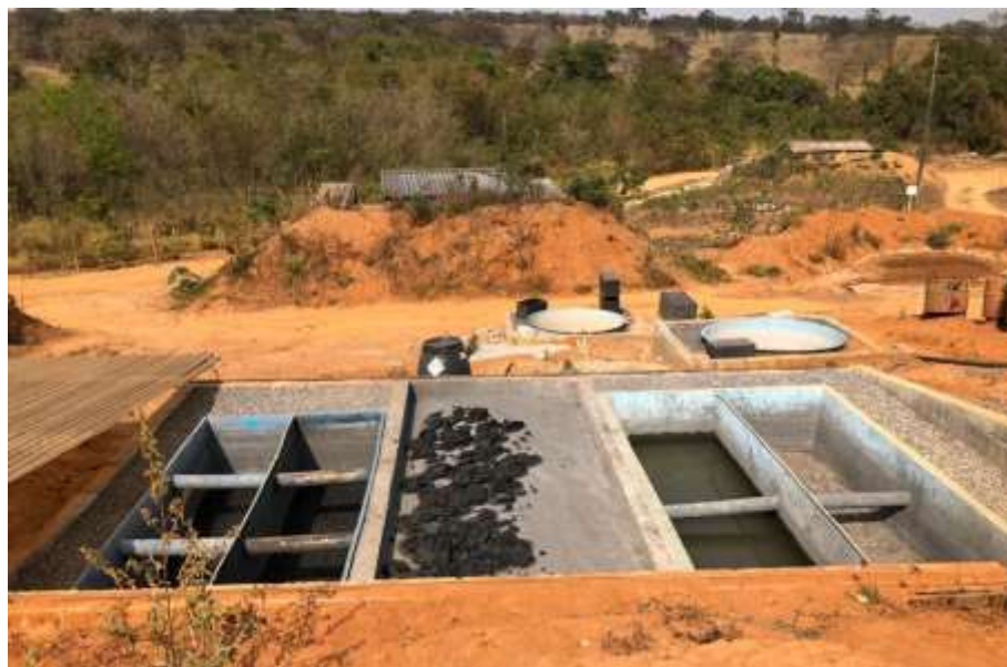
Figura 2 – Leito de secagem dos lodos com uso de coagulantes naturais e químico.
