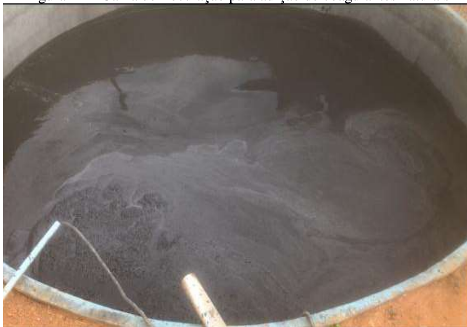
Figura 11 – Caixa de floculação para adição de coagulantes naturais
