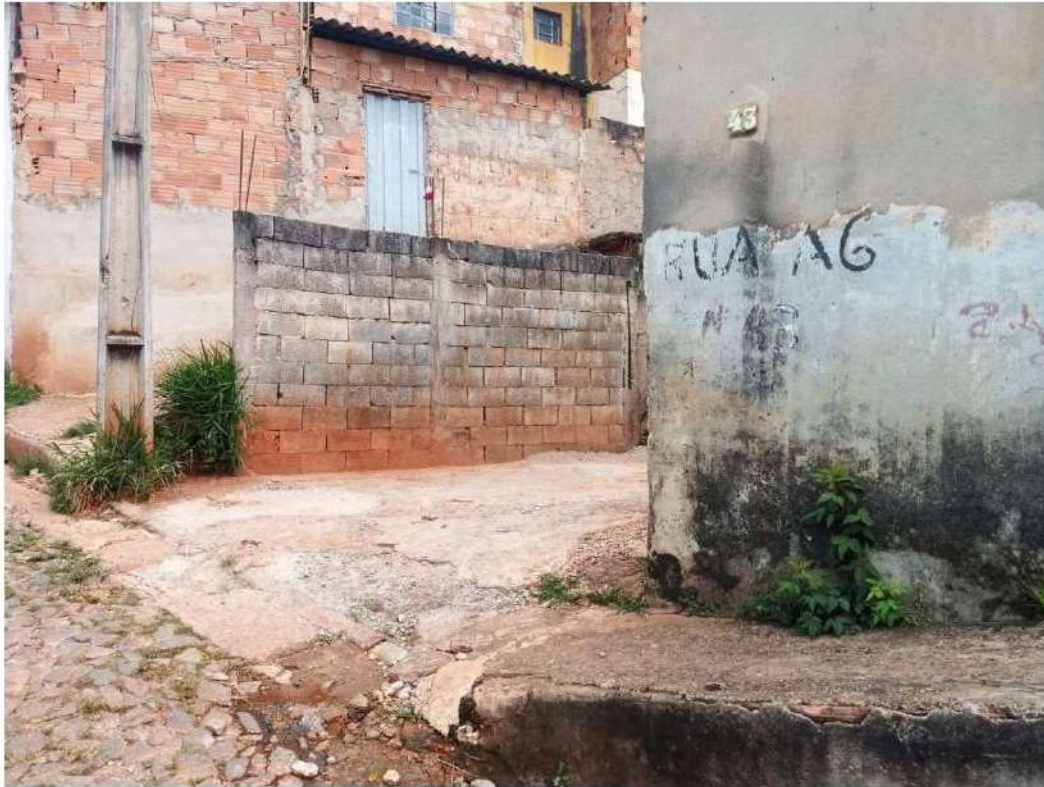
Apêndice 17: local onde foi encontrado o vazamento
