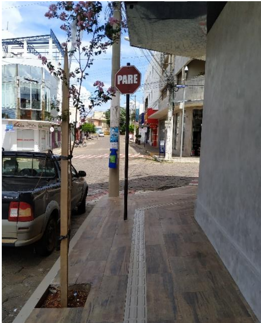
Imagem 23 – Placa desalinhada na calçada P
