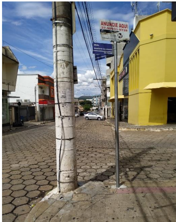
Imagem 8 – Placa instalada na faixa livre
