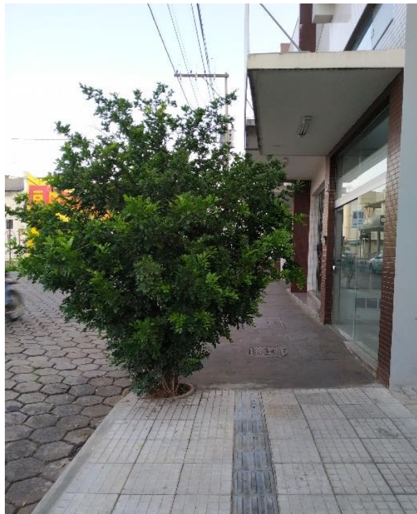
Imagem 20 – Descontinuidade do piso tátil na calçada N
