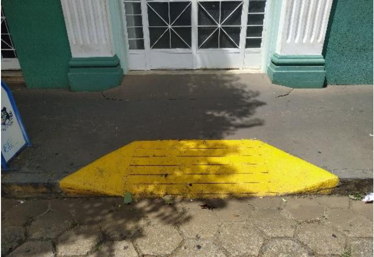
Imagem 28 – Rebaixamento de calçada
