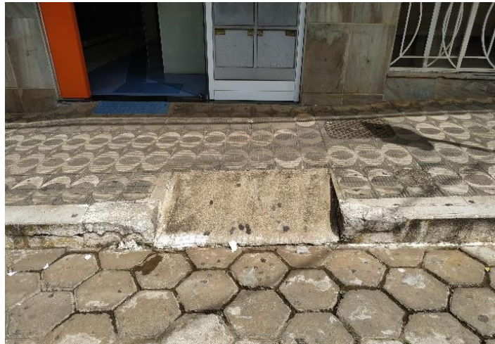
Imagem 9 – Rampa de acesso para PNE na calçada F
