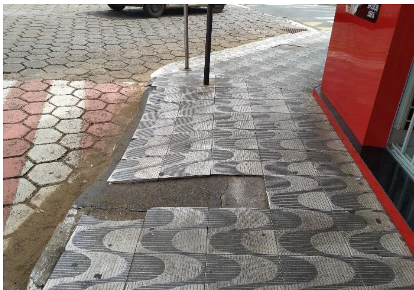
Imagem 7 – Rampa de acesso na calçada D
