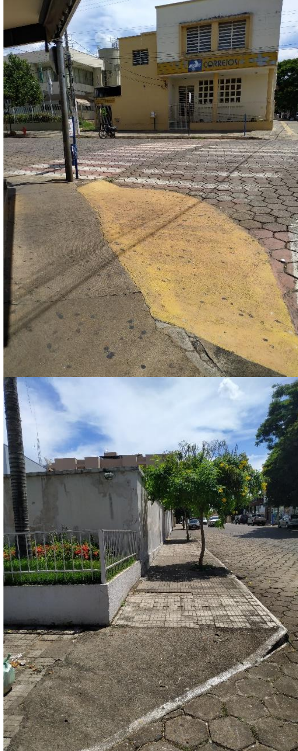
Imagem 3 – Rampas de acesso para PNE
