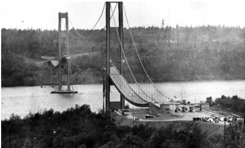
Figura 8 – Ponte Tacoma Narrows pós colapso
