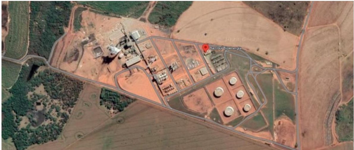
Figura 1 - Instalação da empresa Bambuí Bioenergia S/A
