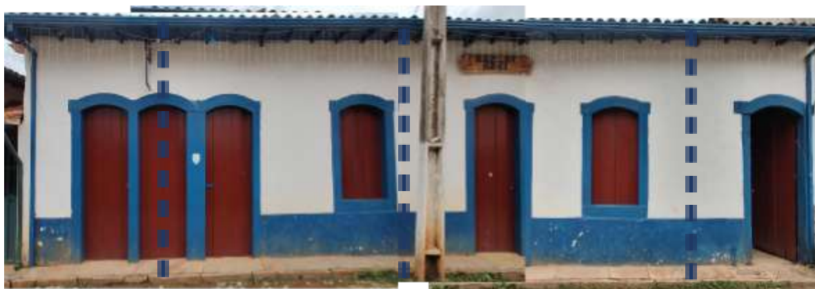
Figura 4 - Vista frontal da fachada da Casa da Festa
