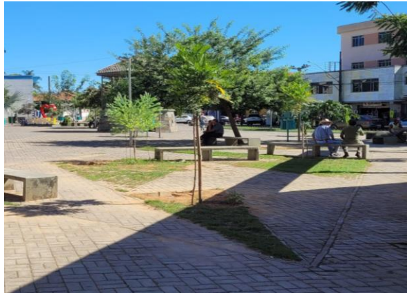
Figura 12 – Área de calçamento da Praça que precisa de replantio.
