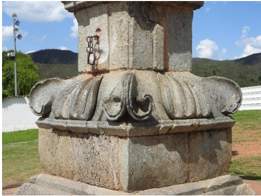
Figura 35: Detalhe da base da coluna ornamentada com curva e contracurva. Fonte: Sabrina Delamore, 2017.
