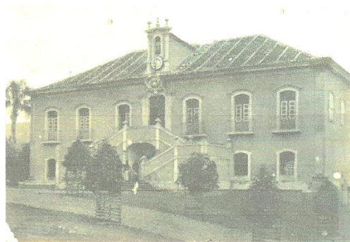
Figura 16: Fotografia da fachada frontal da Casa de Câmara e Cadeira na Praça Minas Gerais, ilustrando a situação urbanística do local, provavelmente da década de 1940 . Fonte: Ficha fotográfica do laudo técnico do Projeto de Revitalização da Praça Minas Gerais, pertencente ao IPHAN – do escritório de Mariana, de 2005.
