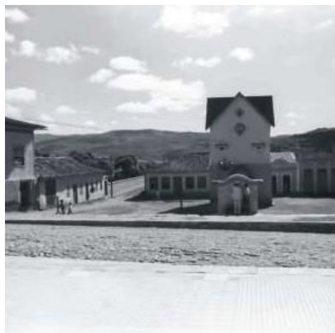
Figura 13: Praça da Sé (Largo da Catedral da Sé). Encontramos a mesma “casa” de força e distribuição de energia (mesma casa que aparece ao lado o monumento do bicentenário, fig.18). Fonte: Grupo do Facebook: Mariana no fundo do baú, enviado por Lauro Soares.
