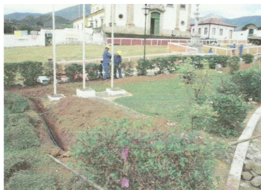
Figura 27: Fotografia da execução da obra de revitalização da Praça Minas Gerais (largo da Casa de Câmara e Cadeira) Mariana – MG. Fonte: IPHAN/Mariana. Relatório Mensal de Avaliação de Obras (Revitalização da Praça Minas Gerais). Nº1, Maio – Outubro de 2006.
