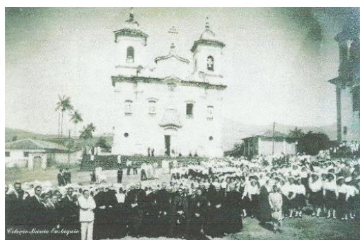
Figura 17: Fotografia da Praça Minas Gerais, ilustrando a situação urbanística do local, bem como as comemorações religiosas e civis, provavelmente da década de 1950 . Fonte: Ficha fotográfica do laudo técnico do Projeto de Revitalização da Praça Minas Gerais, pertencente ao IPHAN – do escritório de Mariana, de 2005.
