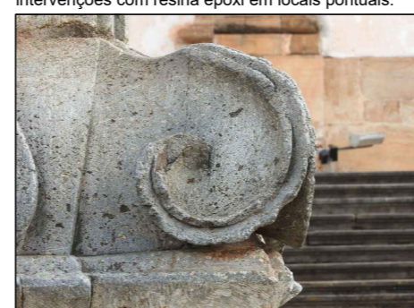
Fig. 6: A voluta do canto direito apresenta desgastes em suas extremidades, além da parte interior que está parcialmente perdida. Há sinais de vandalismo e crosta negra em sua extensão.
