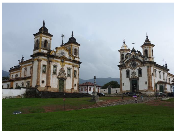
Figura 41: Iluminação pública da Praça Minas Gerais totalmente subterrânea. Fonte: Sabrina Delamore, 2017.
