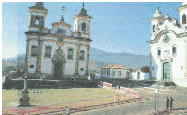
Figura 26: Fotografia da execução da obra de revitalização da Praça Minas Gerais, (largo da Igreja de São Francisco de Assis) Mariana – MG. Fonte: IPHAN/Mariana. Relatório Mensal de Avaliação de Obras (Revitalização da Praça Minas Gerais). Nº1, Maio – Outubro de 2006.
