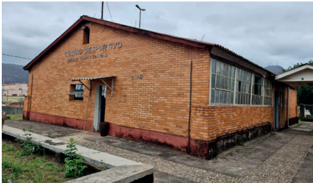
Figura 1 – Local cedido ao Canteiro Experimental em Conservação-Restauração
