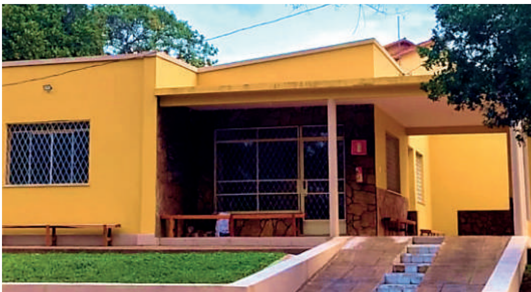
Figura 1 - Fachada da sede do Museu de Zoologia do IFMG-SJE
