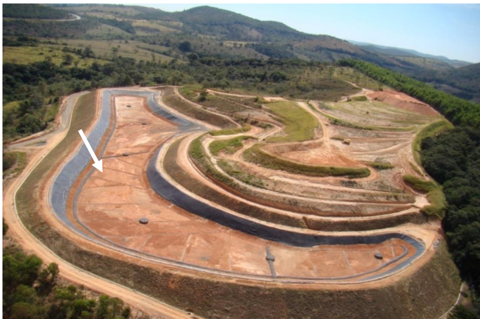
Figura 4 – Seta indicando a primeira plataforma do Aterro Sanitário de Formiga –MG “Marcelo Reis Arantes”
