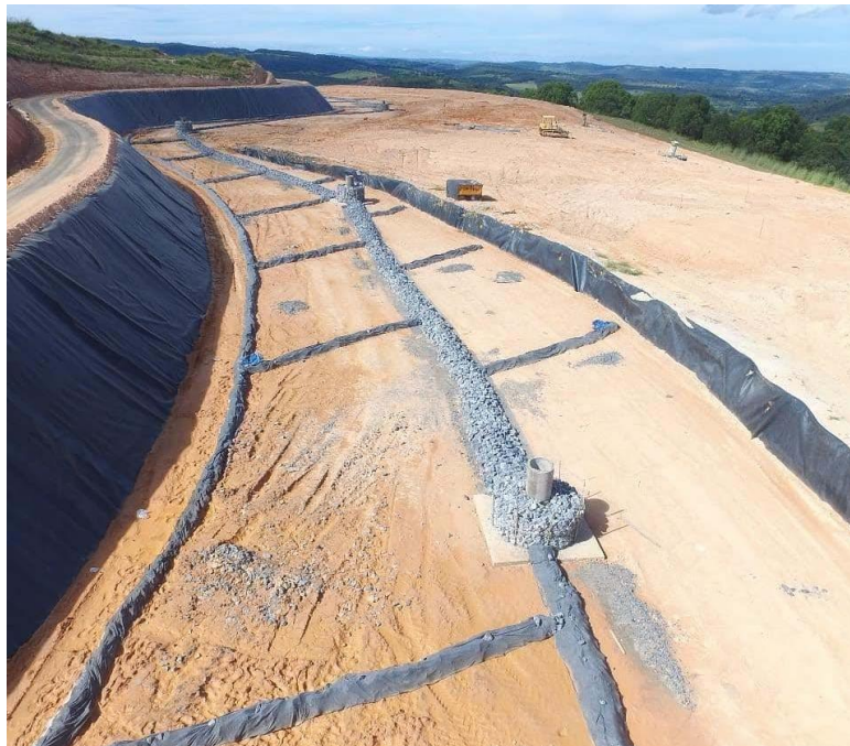
Figura 6 – Drenagem de chorume e impermeabilização com geomembrana de PEAD na terceira plataforma
