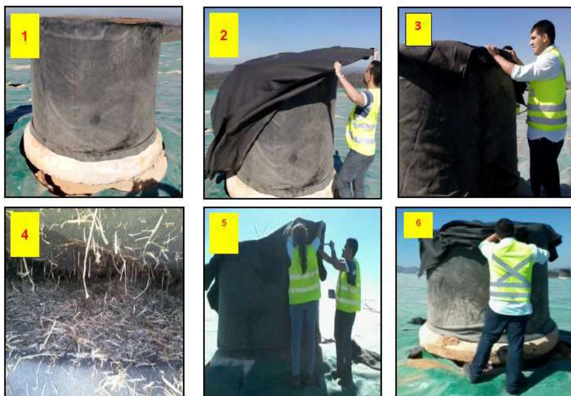
Figura 14 – Etapas de instalação de biofiltro
