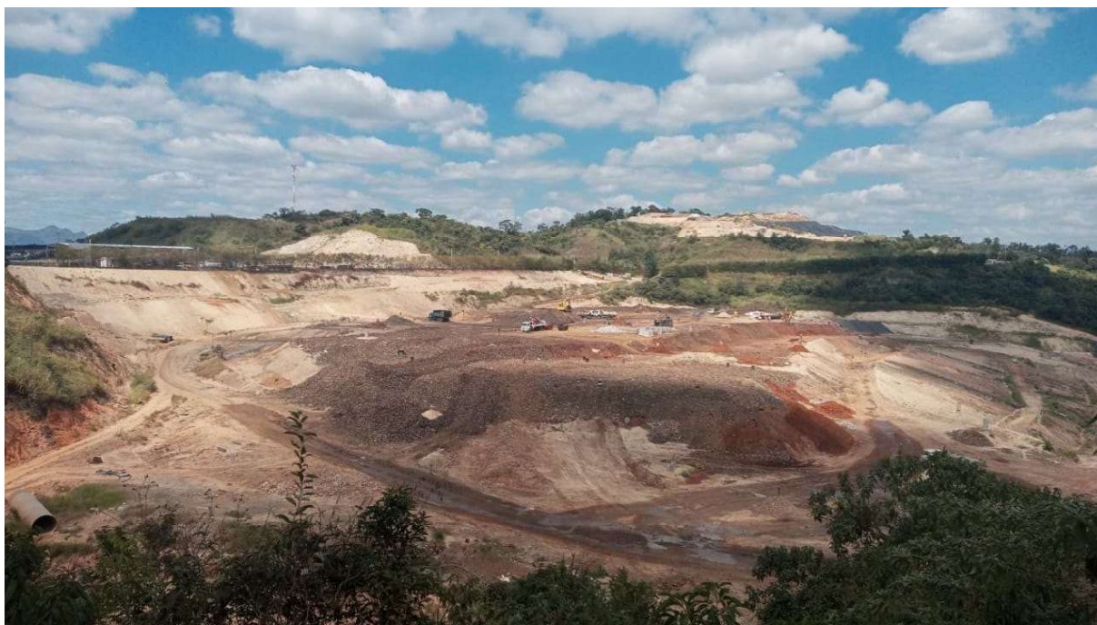
Figura 08 – Cobertura de resíduos com solo
