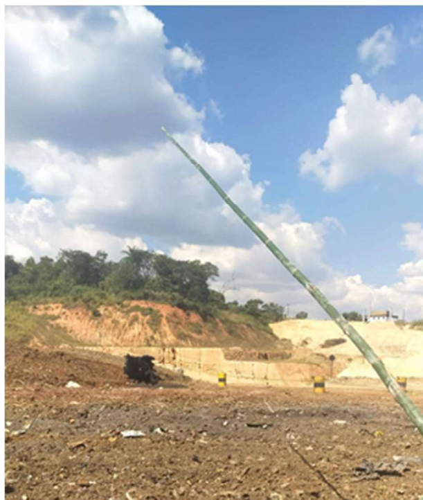
Figura 21 – Espantalho urubu instalado na frente de trabalho
