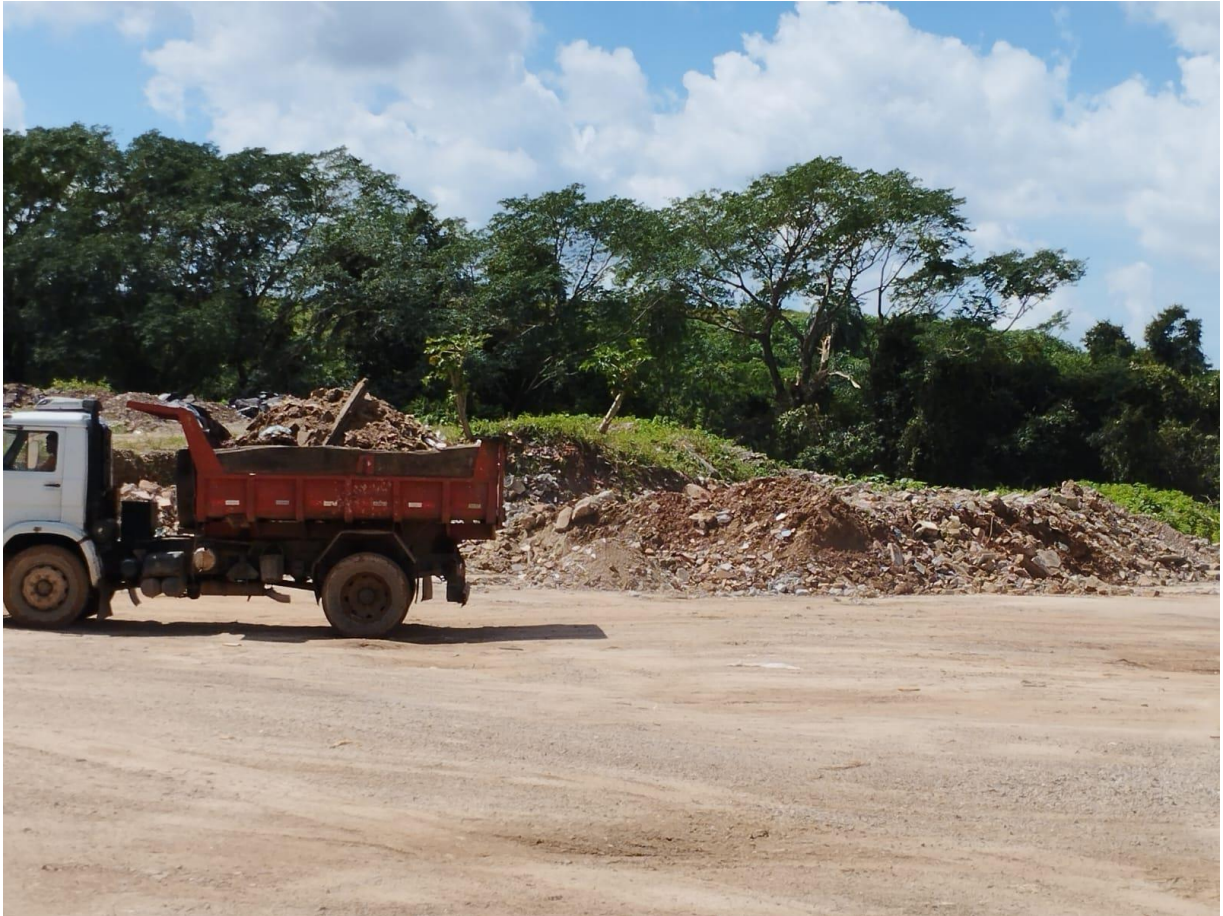
FIGURA 9 - ÁREA DE RECEBIMENTO DE ENTULHO DA USINA
