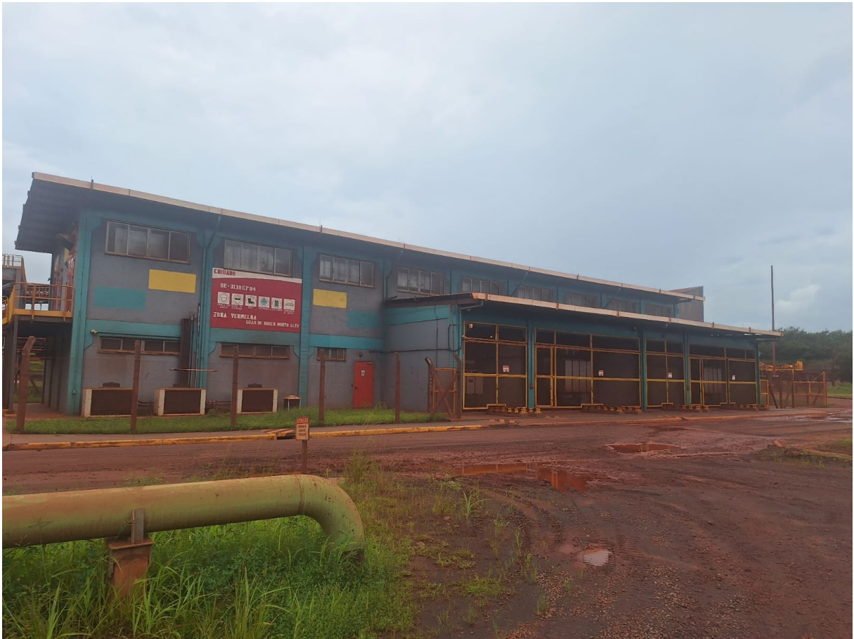
Figura 10 – Sala de Controle SE-3130KP-04
