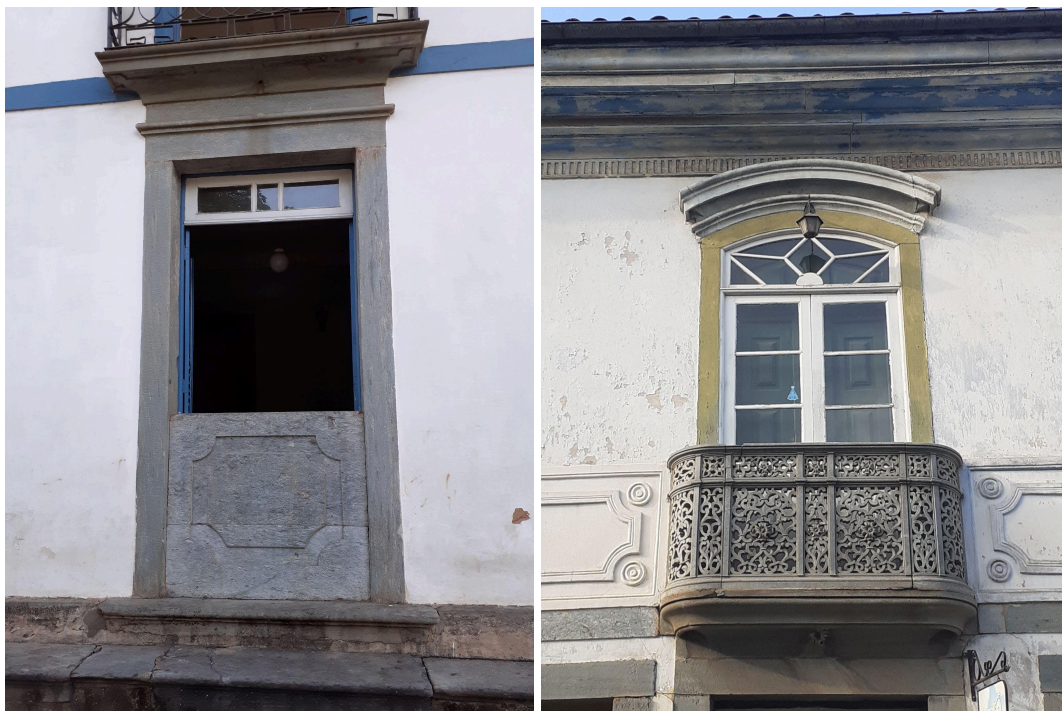
Figura 14: Janelas com peitoril entalado, na rua Barão de Camargos e com sacada, na rua Direita. Ambas em Mariana.
