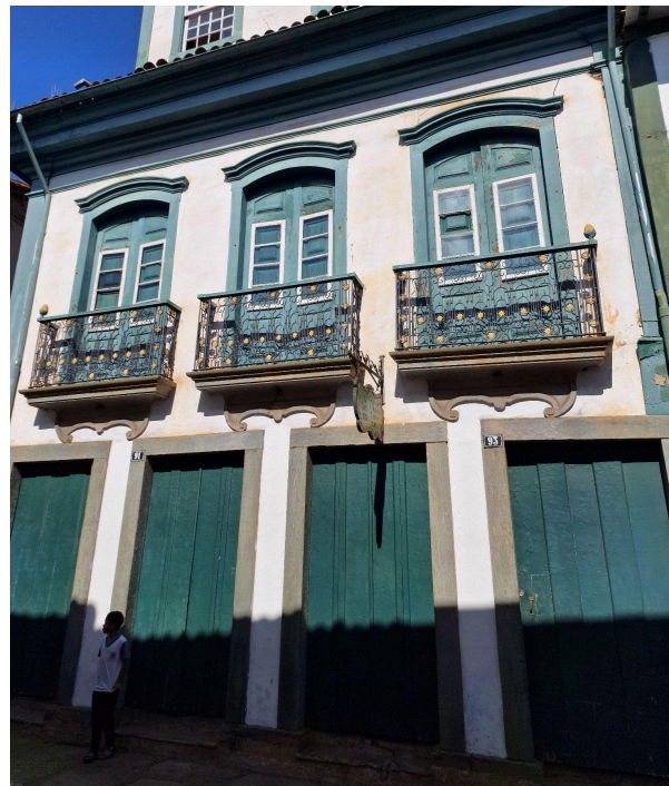
Figura 10: Contraste da simplificação das esquadrias do pavimento térreo em comparação com o segundo pavimento em edificação da rua Direita em Mariana.
