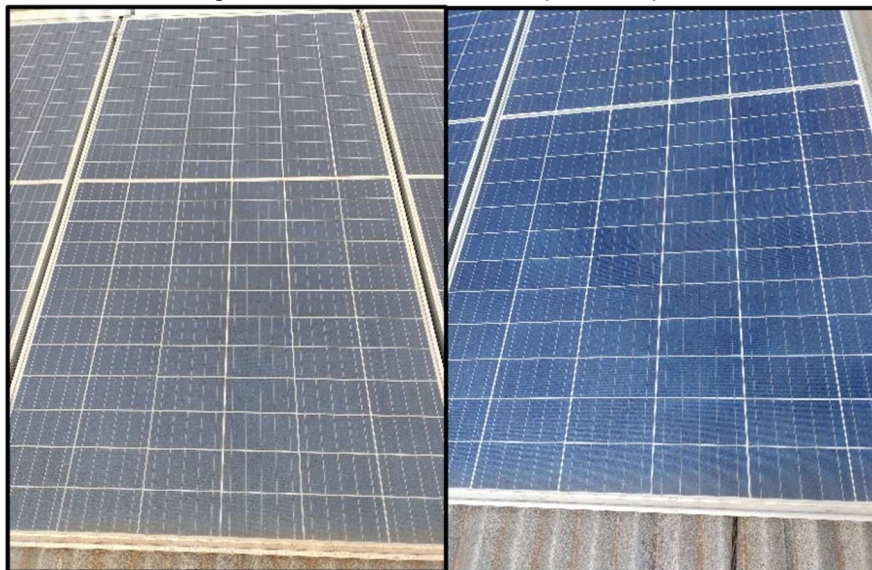
Figura 12 - Módulos antes e após a limpeza
