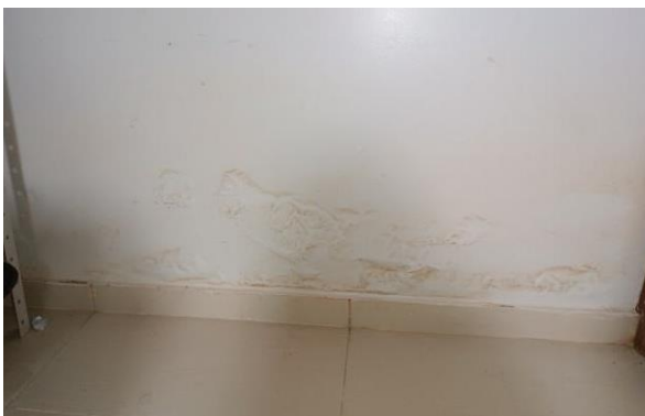
Figuras 06 (a); (b): Descascamento e estufamento da pintura. Fonte: Autoras (2023).
