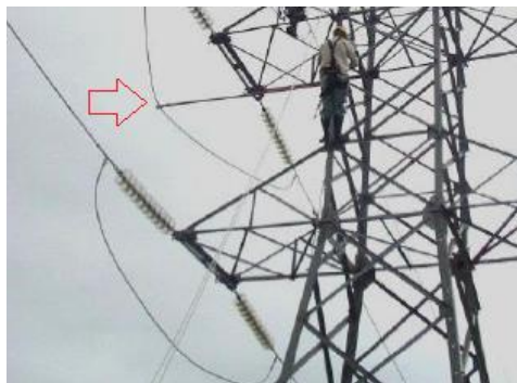
Figura 31: Afastamento do jumper superior.
