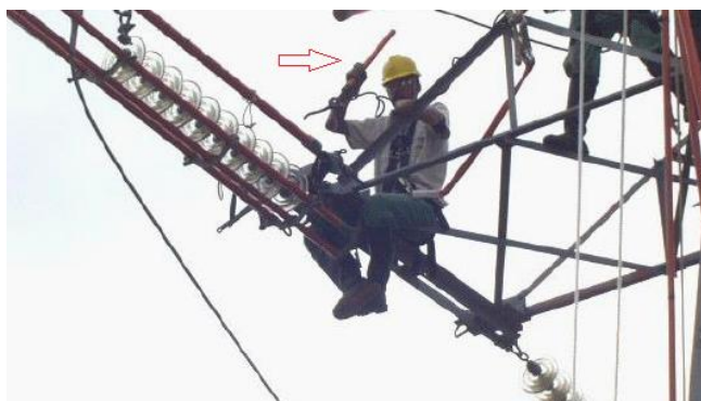
Figura 39: Eletrícista instalando o aterramento estático.
