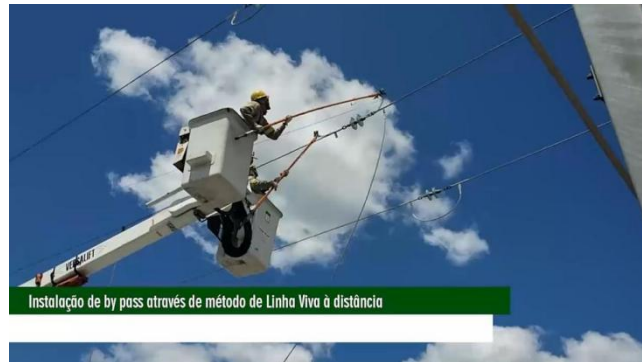
Figura 3: Instalação de by-pass através do método de linha viva a distância.
