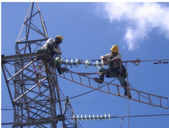
Figura 46: Eletricista posicionado na escada sacando o contrapino da concha.
