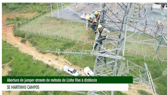
Figura 2: Abertura de jumper através do método de linha viva a distância.
