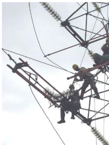
Figura 40: Sacando a cadeia de isoladores.
