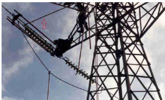
Figura 38: Eletricista sacando contrapino e boleto da concha.
