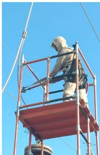
Figura 4: Entrando no potencial através do método de linha viva ao potencial.
