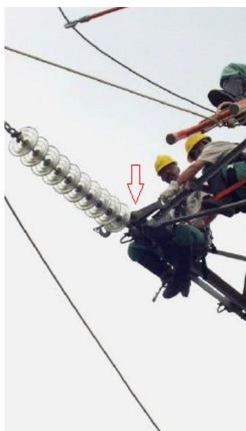
Figura 32: Instalação do jugo morto na ponta da mísula.
