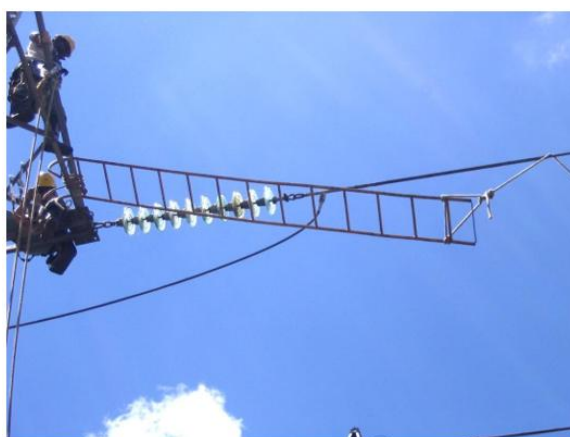
Figura 43: Instalação da escada trapézio na mísula.
