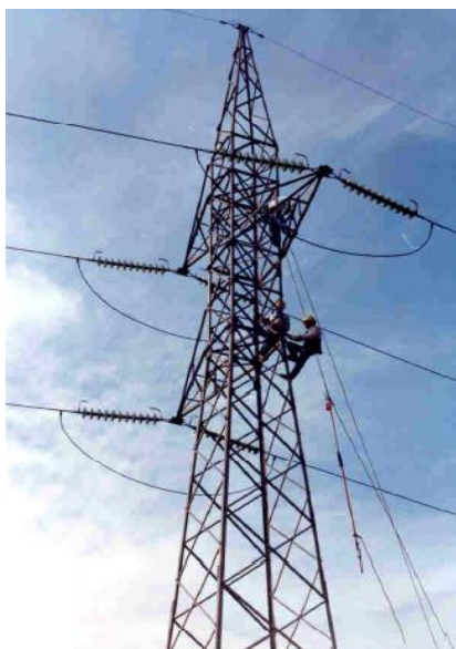
Figura 41: Finalizando a troca de isoladores.
