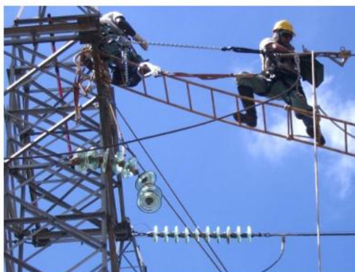
Figura 47: Momento da descida da cadeia de isoladores.
