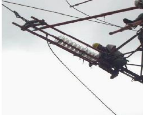
Figura 37: Berço já fixado entre o julgo vivo e morto.
