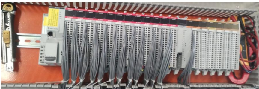
Figura 19 - Montagem dos cartões de entrada e saída
