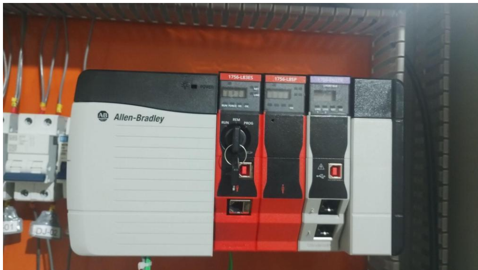
Figura 13 - CLP utilizado na implantação do projeto
