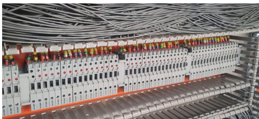
Figura 20 - Instalação das régulas de borne nos painéis
