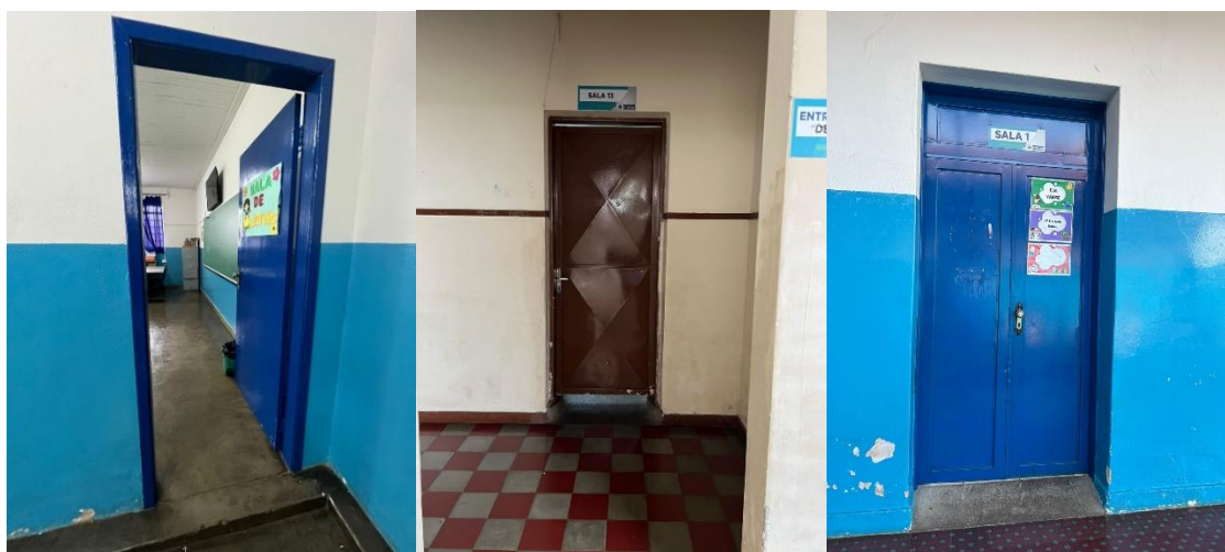
Figura 17 - Tipo de soleiras verificadas nas escolas pesquisada considerando presença ou ausência de desnível nas escolas A, D e G respectivamente
