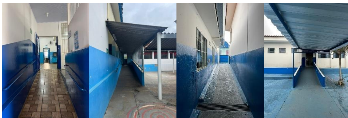
Figura 9 - Exemplos de rampas com proteção lateral encontradas na área de circulação nas escolas B, C, F e F, respectivamente
