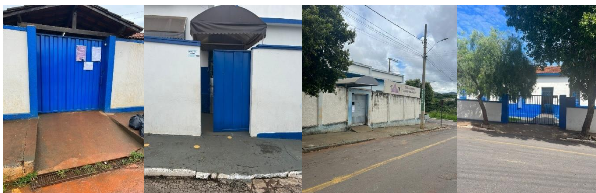
Figura 4 - Irregularidades encontradas nas calçadas para entrada das escolas A, B, E e G, respectivamente
