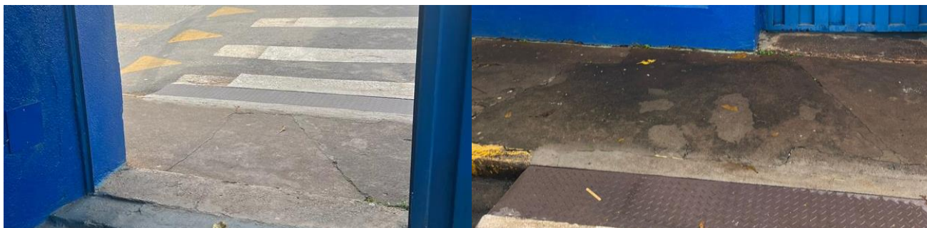
Figura 5 - Platô de ferro para acesso a escola F, dos ângulos interno e externo, respectivamente.
