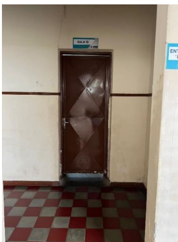
Figura 18 - Portas na escola D, com destaque para o tipo de maçaneta e largura da porta
