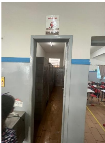
Figura 22 - Portas do Banheiro na Escola E, com destaque para largura da porta
