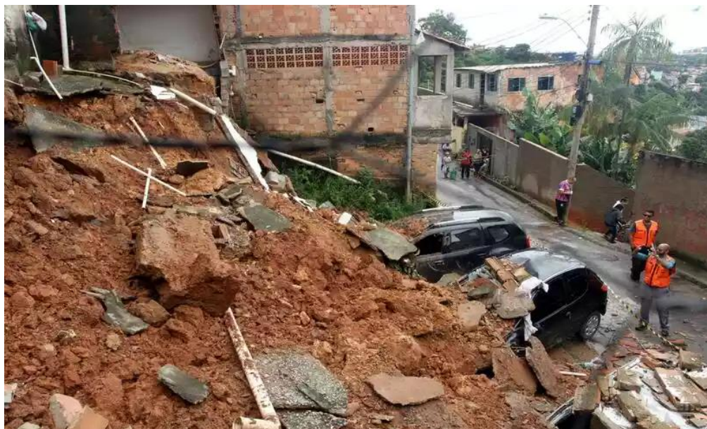
Figura 3 – Movimento de massa na regional Centro-Sul de Belo Horizonte
