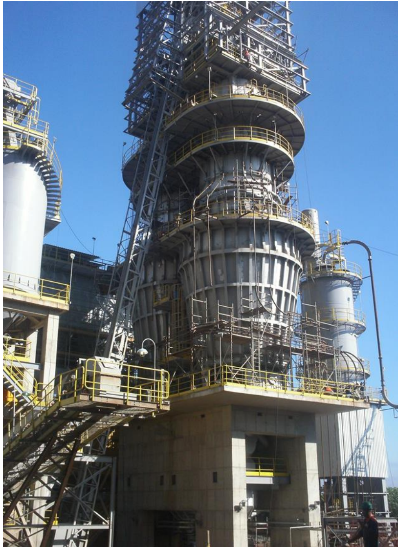
Figura 1. Forno Vertical de Fluxo Paralelo Regenerativo. Fonte: (Lhoist, 2017)
