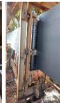
Instalação de roletes guia para evitar danos por contato estrutural com a correia
