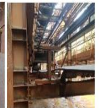
Pior Trecho Entre a 5ª e 6ª Emendas, provocou a quebra do Rolete Vertical de Alinhamento.
