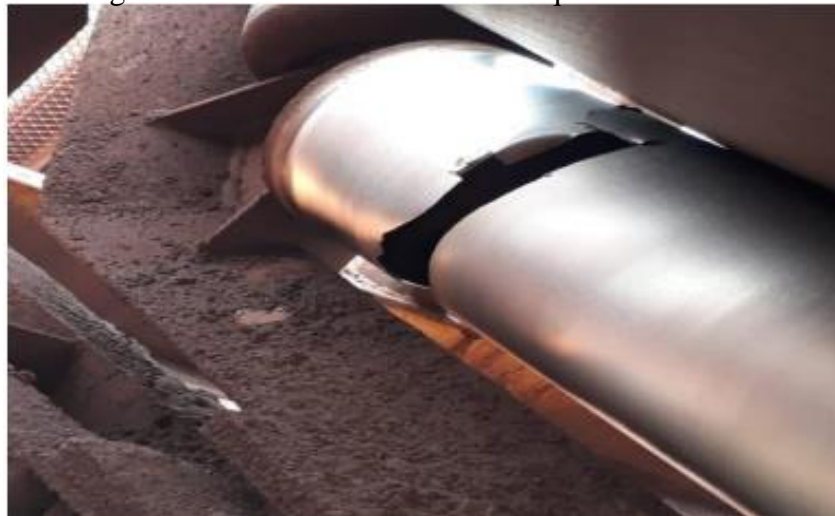
Figura 21 – Rolo com revestimento quebrado
