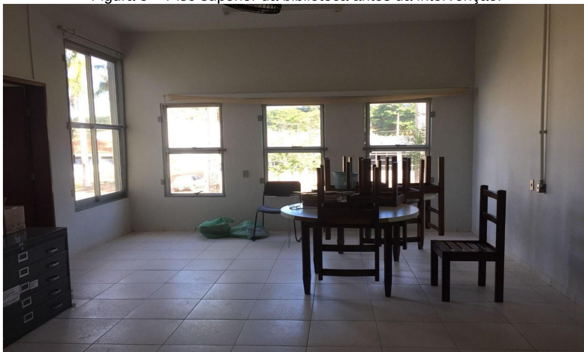
Figura 5 – Piso superior da biblioteca antes da intervenção.
