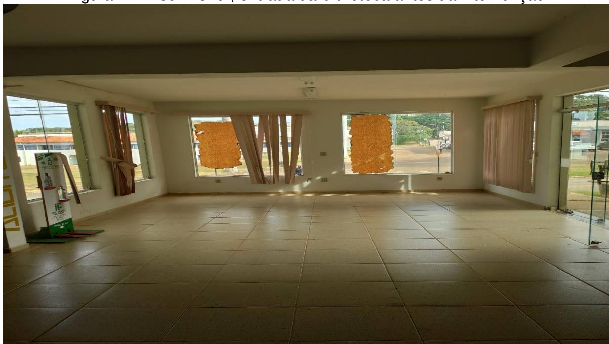
Figura 7 – Piso inferior, entrada da biblioteca antes da intervenção.
