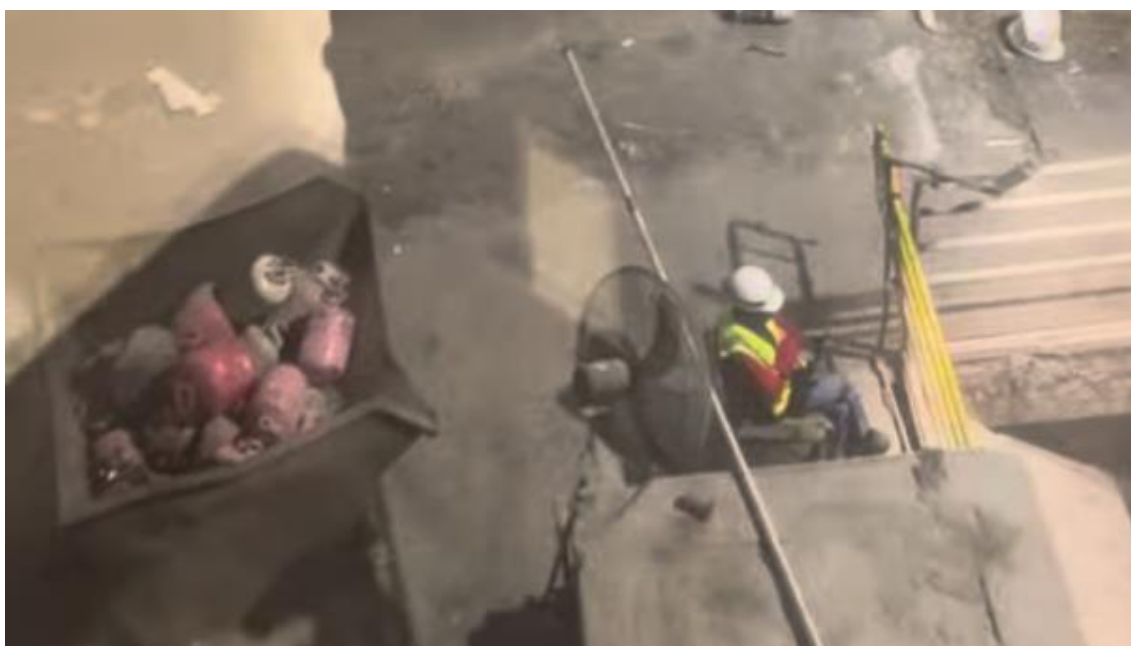
Figura 12 - Operador em posto de inspeção visual, portando haste mecânica de remoção ao lado da caçamba de contenção
