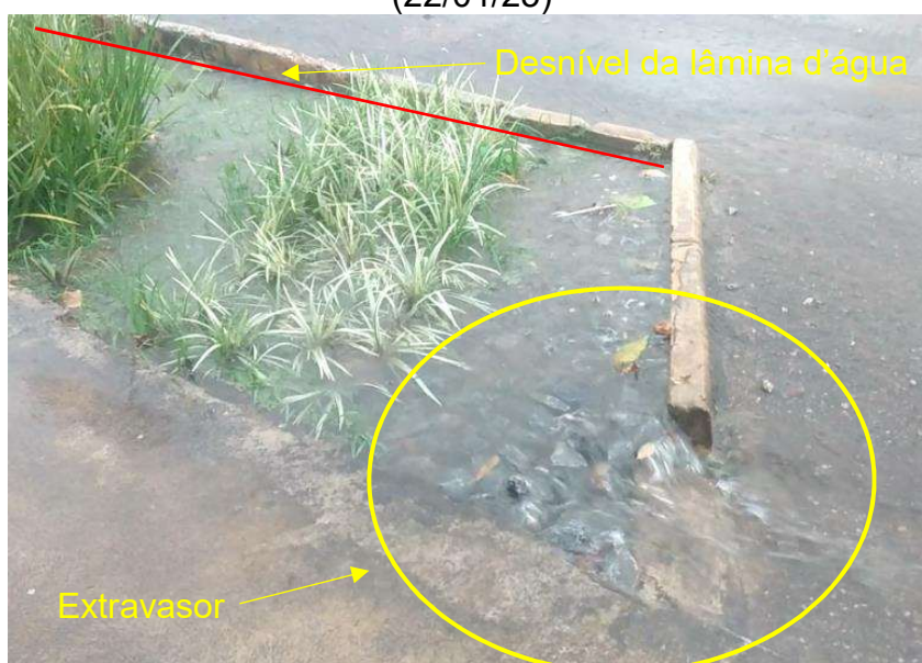
Figura 6.8 – Lâmina d'água variável em função da declividade do dispositivo nº 9 (22/01/25)
