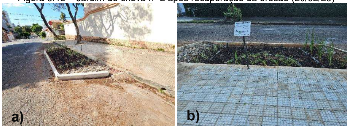
Figura 6.12 – Jardim de chuva nº 2 após recuperação da erosão (20/02/25)
