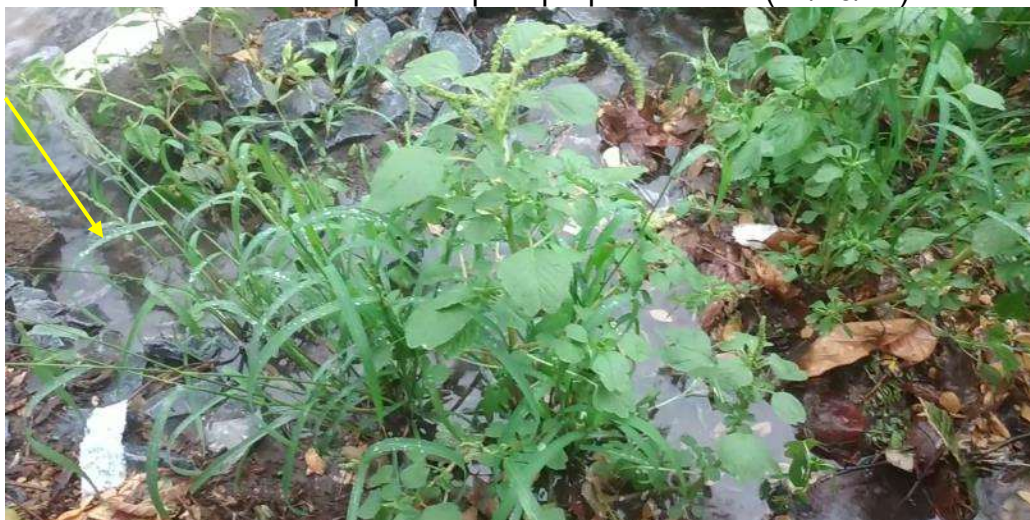
Figura 6.6 – Detalhe da entrada do jardim de chuva nº 8 com captação do escoamento superficial pela pequena fenda (27/10/24)
