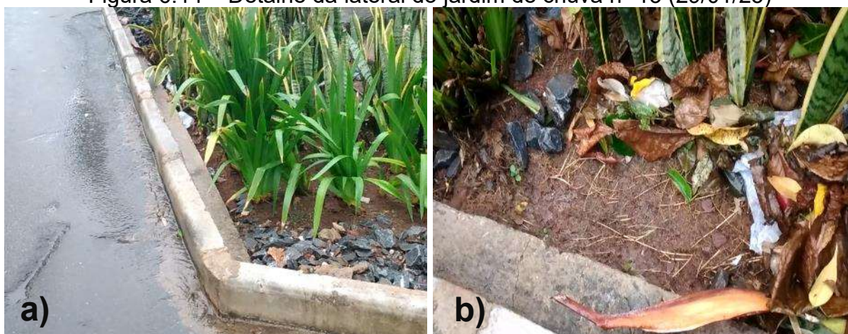
Figura 6.14 – Detalhe da lateral do jardim de chuva nº 13 (29/01/25)
