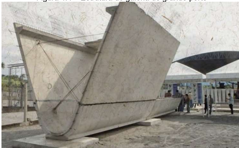
Figura 4.4 – Estrutura de galeria de grande porte
