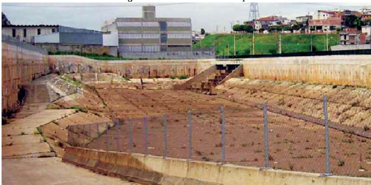
Figura 4.6 – Bacia de detenção
