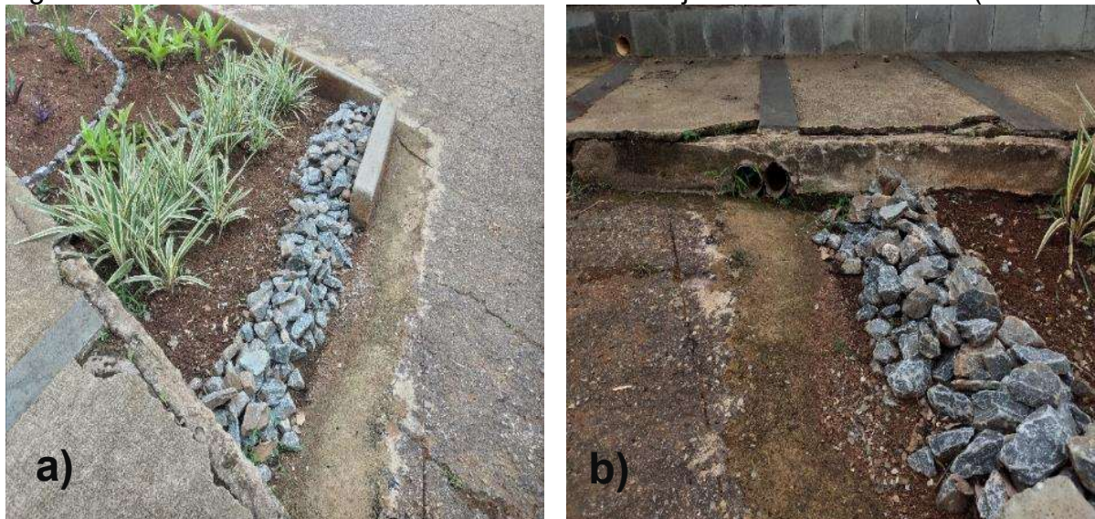
Figura 6.2 – Detalhe da faixa de brita da entrada do jardim de chuva nº 14 (15/12/24)
