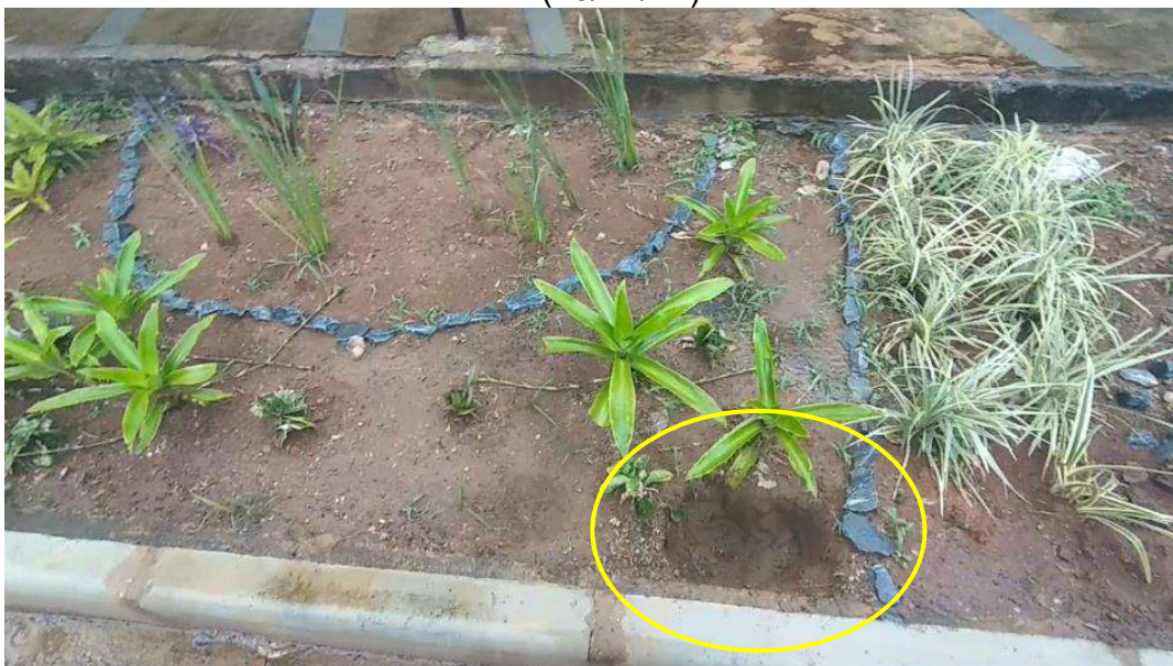
Figura 6.13 – Destaque da pequena erosão na porção central do jardim de chuva nº 14 (28/12/24)
