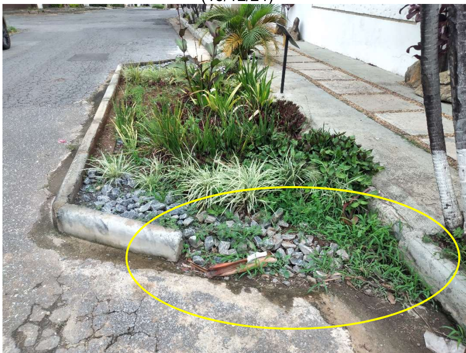
6.16 – Detalhe da entrada com uma largura maior do jardim de chuva nº 22 (15/12/24)
