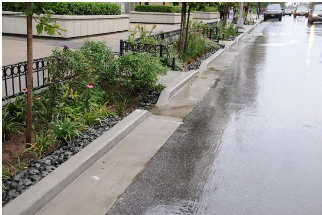
Figura 6.18 – Exemplo de jardins de chuva em Nova Iorque (EUA) com entradas laterais
