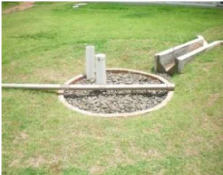
Figura 4.10 – Poço de infiltração
