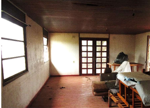
Sala de estar da edificação pré-moldada em Vilhena/RO, 2021. Fonte: Acervo da autora, 2021
