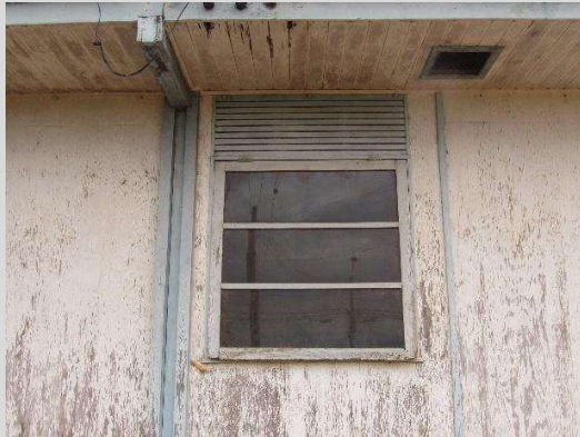
Janela padrão da edificação pré-moldada em Vilhena/RO, fachada lateral, 2021. Fonte: Acervo da autora, 2021.
