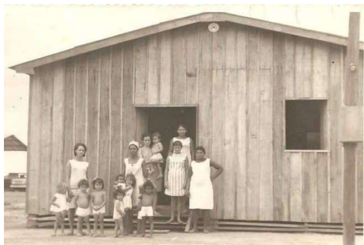
Figura 3 - Tipologia de moradia em madeira em meados de 1970 em Vilhena.
