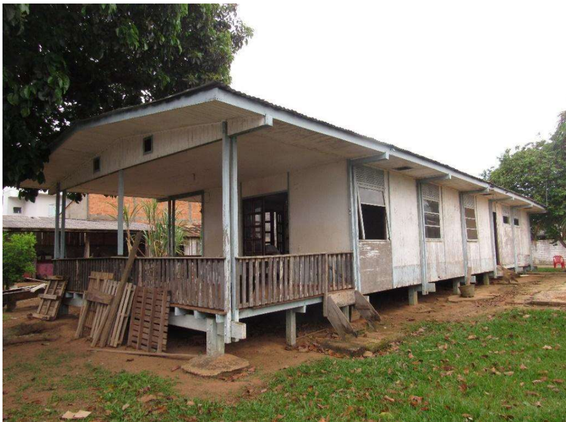
Figura 6 - Fotografia da edificação remanescente das instalações do 5º BEC.
