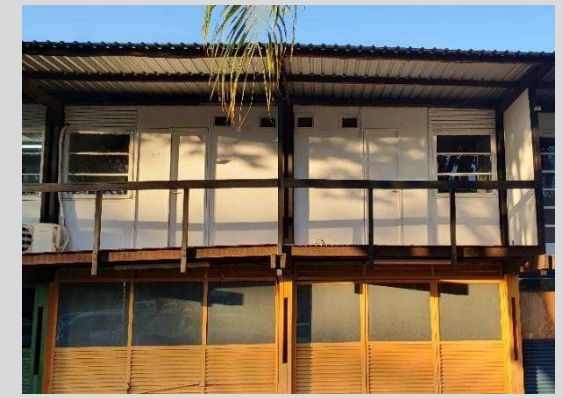
Painéis de vedação do Bloco OCA II - UNB em Brasília - Sérgio Rodrigues. Fonte: Acervo da autora, 2023.
