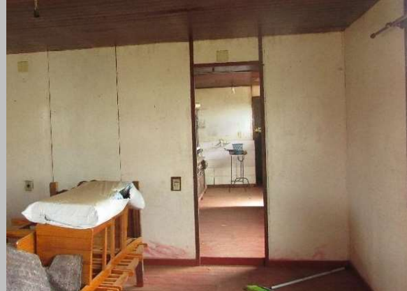
Detalhe da porta - edificação pré-moldada em Vilhena/RO, fachada lateral, 2021. Fonte: Acervo da autora, 2021.
