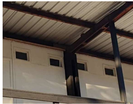
Aberturas do Bloco OCA II - UNB em Brasília - Sérgio Rodrigues. Fonte: Acervo da autora, 2023.
