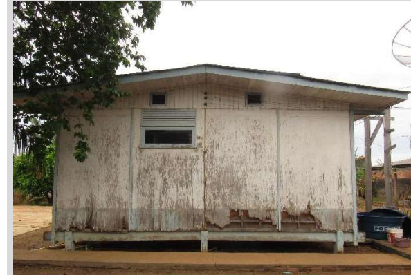
Painéis de vedação da edificação pré-moldada em Vilhena/RO, fachada posterior, 2021. Fonte: Acervo da autora, 2021.
