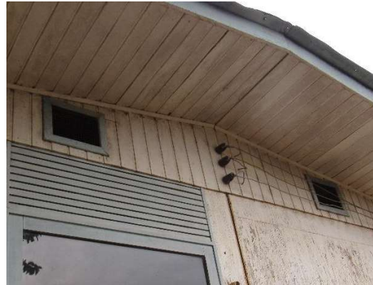
Aberturas da edificação pré-moldada em Vilhena/RO, fachada lateral, 2021. Fonte: Acervo da autora, 2021.
