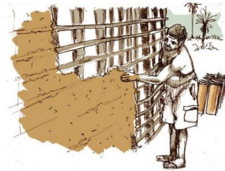
Parede de pau-a-pique tendo o barro compactado com as mãos. (Teoria, História e crítica da arquitetura e do urbanismo II – TH2. PUC Goiás, s.d.)
