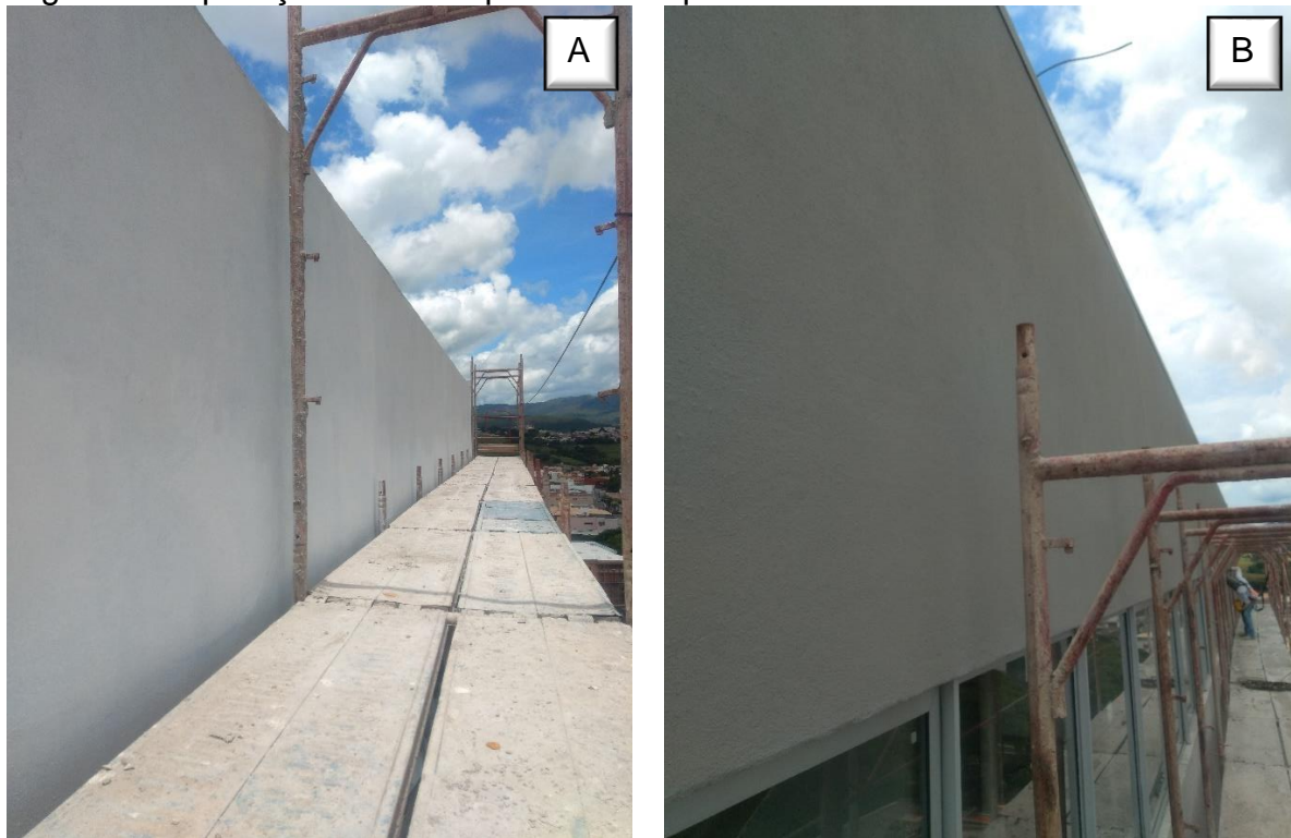
Figura 24: Aplicação de fundo polimérico e pintura
