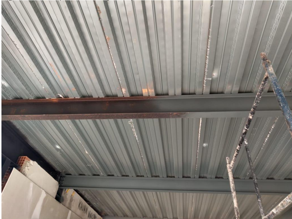
Figura 27: Limpeza, correção e pintura das estruturas metálicas
