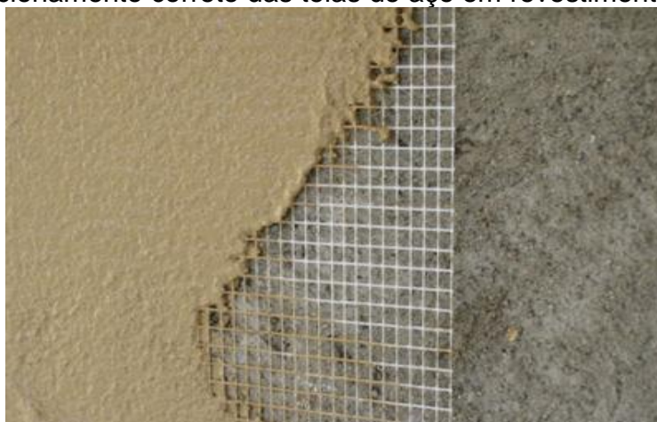
Figura 4: Posicionamento correto das telas de aço em revestimento argamassado
