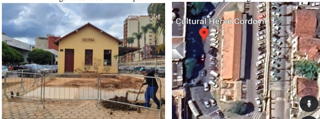
Figuras 59 e 60: Demolição e vista aérea da construção irregular em 2022
