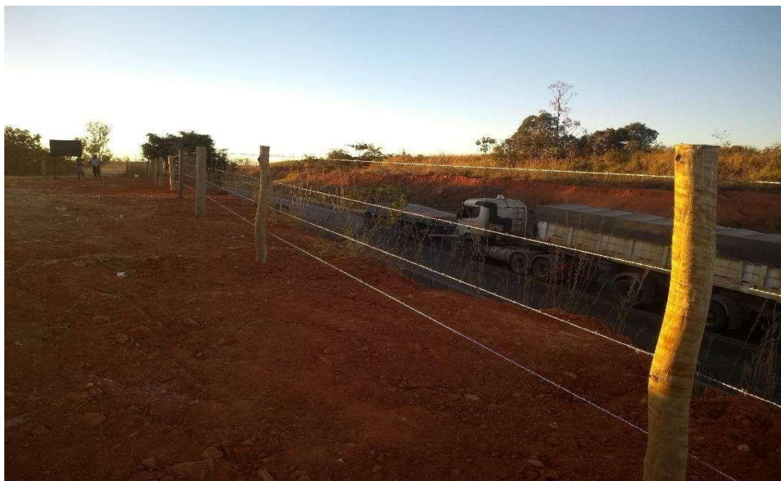
Figura 51 – cercamento do perímetro do aterro
