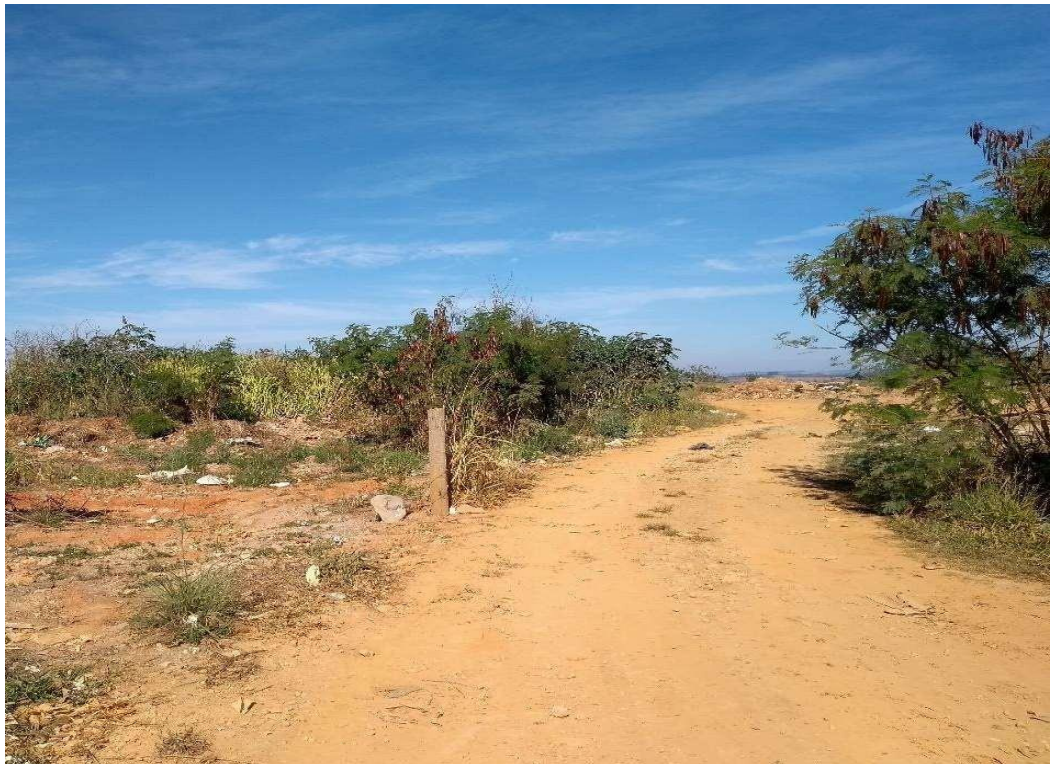
Figura 56 – Ausência de cerca da entrada do aterro municipal
