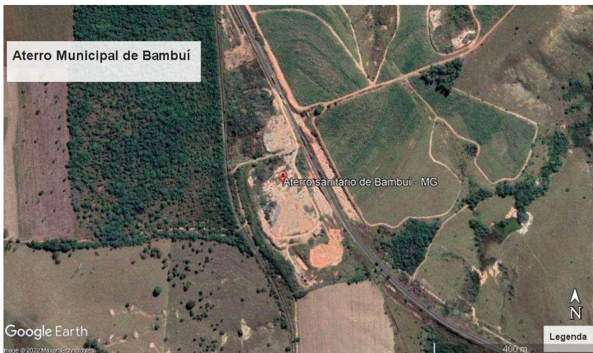
Figura 32 – Aterro em julho de 2022
