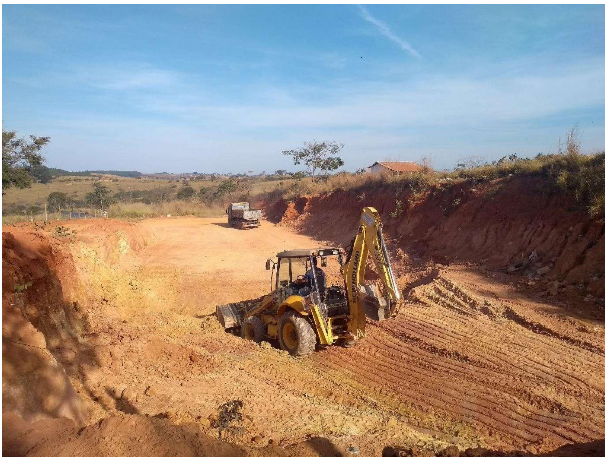
Figura 49 – Mobilização para retirada de material inerte próximo à rodovia
