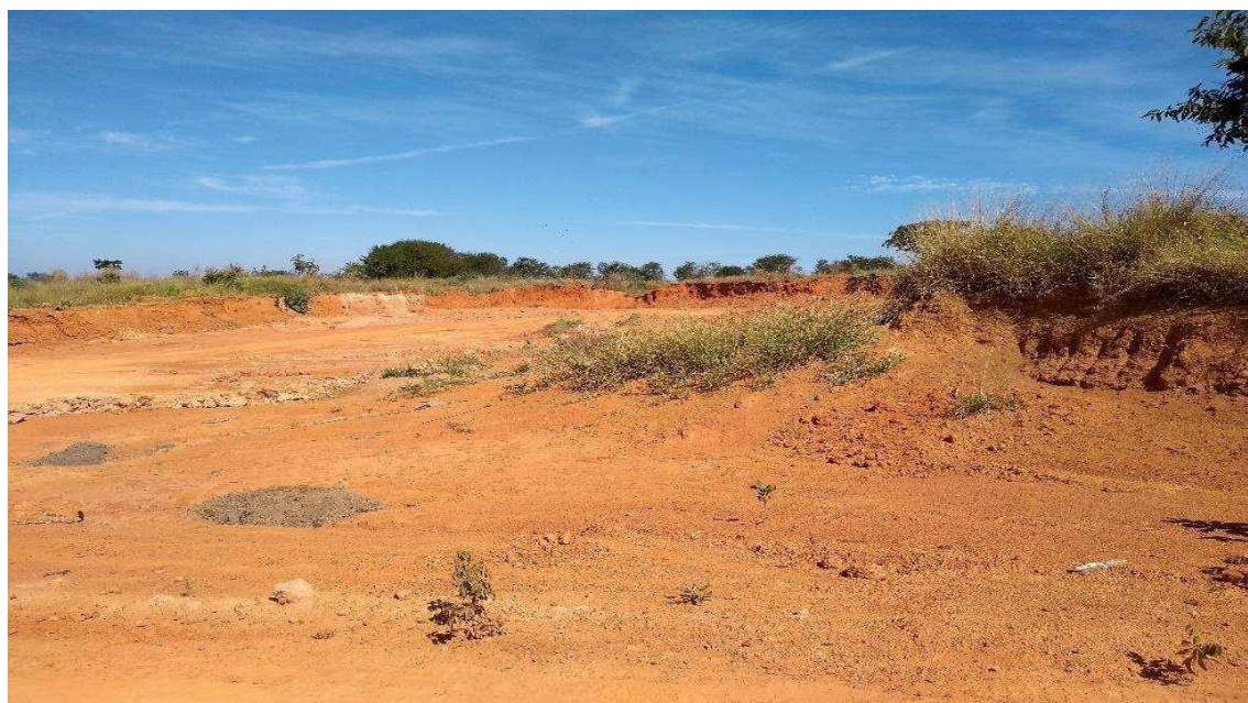
Figura 48 – Processo erosivo da área de empréstimo dentro de Reserva Legal
