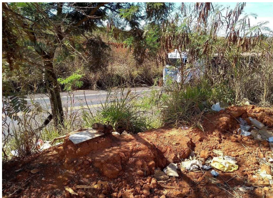
Figura 42 – Proximidade da BR354 ao aterro municipal
