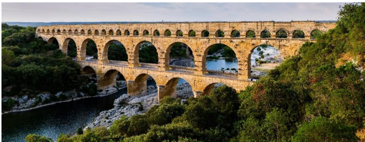
Figura 1 - Pont du Gard, França. Aqueduto romano do século I a.C., construído com argamassa à base de cal e materiais pozzolânicos, preservado até os dias atuais.
