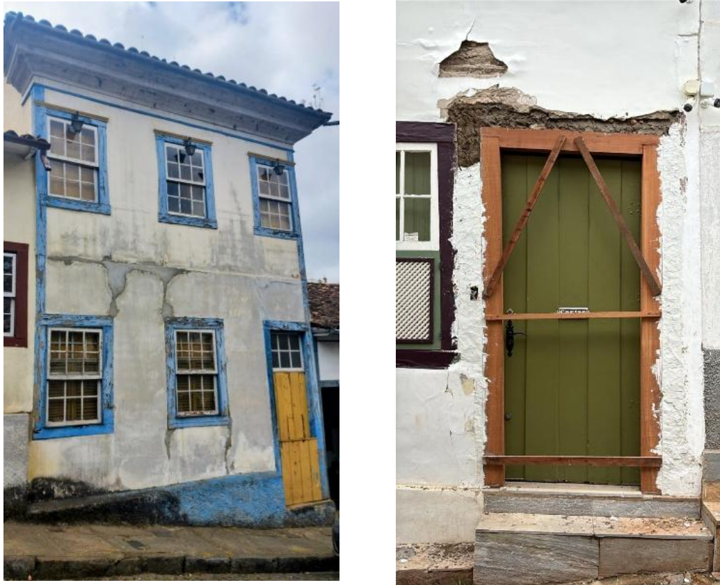
Figura 13 - Exemplos de intervenções em edificações históricas de Ouro Preto/MG: área de reparo curativo visualmente distinta do revestimento original em fachada histórica (esquerda) e aplicação de massa corrida em fachada tombada flagrada no momento da execução (direita).
