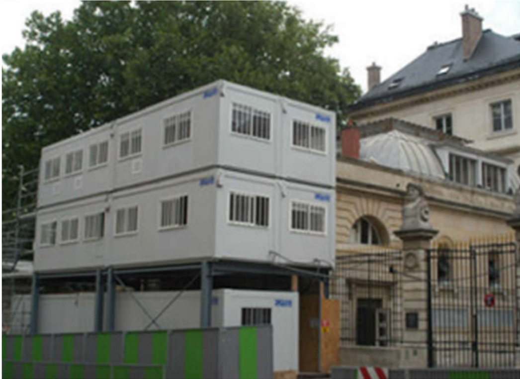
Figura 2: Construções provisórias modulares
