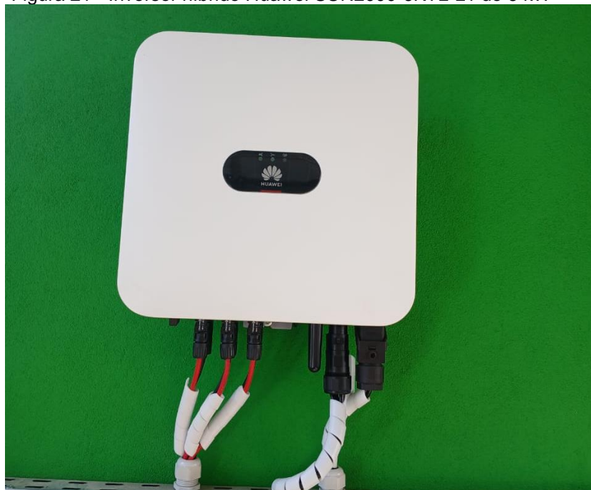
Figura 21 - Inversor híbrido Huawei SUN2000-6KTL-L1 de 6 kW
