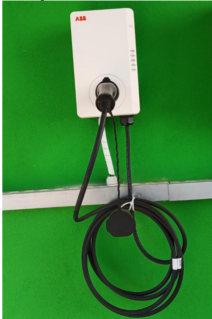
Figura 23 - Carregador veicular ABB Terra AC W7-G5-R-0 de 7,4 kW
