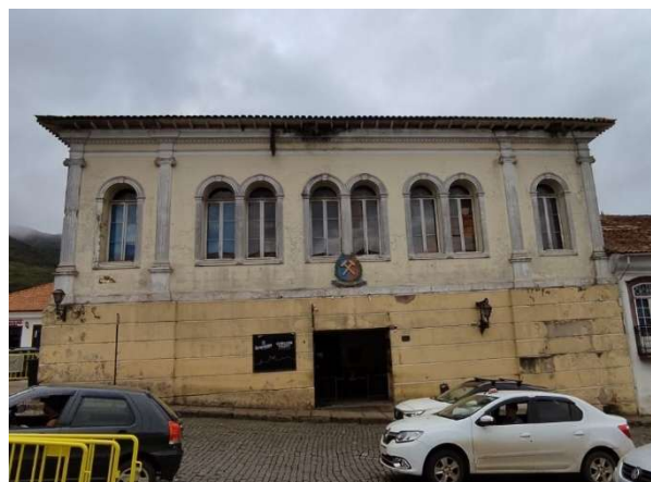
Figura 8 - Vista frontal da fachada do edifício PC2, ano 2024.
