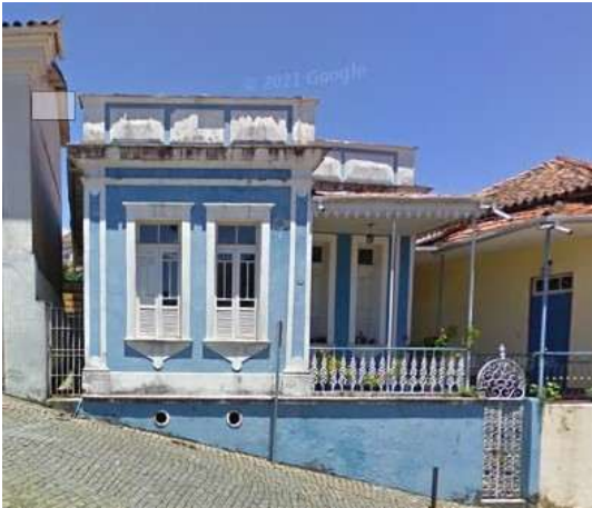
Figura 35- Vista em perspectiva da fachada do edifício EC6, ano 2009.
