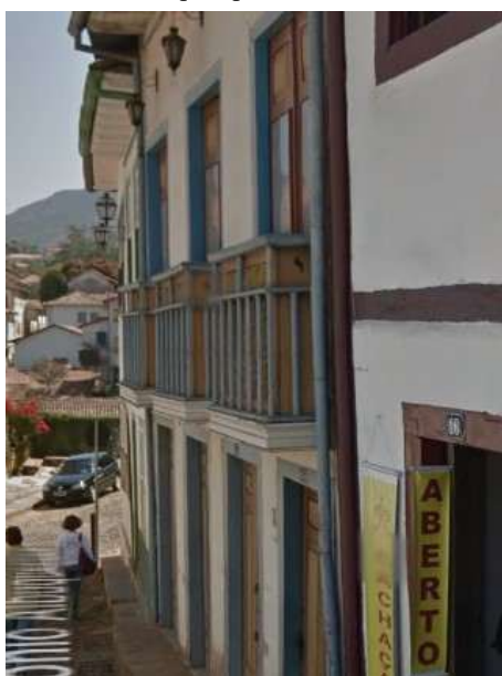
Figura 41- Edifício da rua Antônio de Albuquerque, ano 2009.
