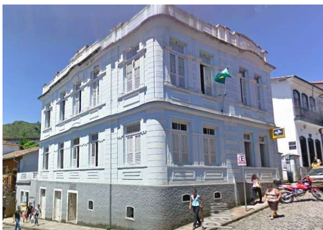
Figura 25- Vista em perspectiva da fachada do edifício EC1, ano 2009.
