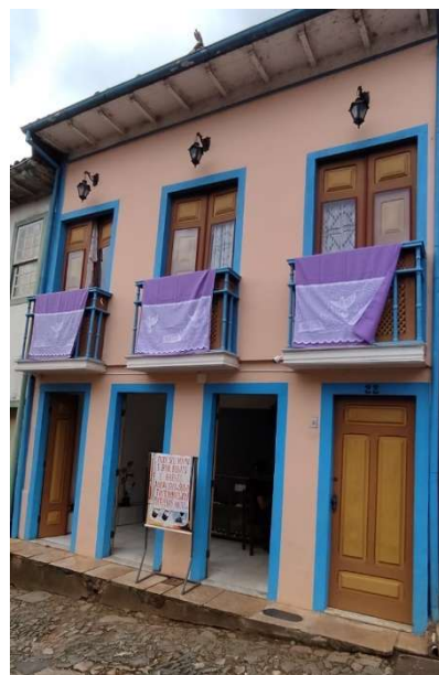
Figura 40- Edifício da rua Antônio de Albuquerque, ano 2024.
