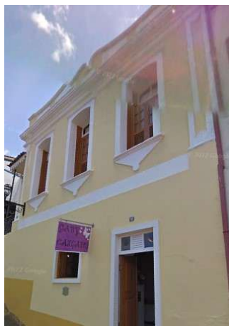
Figura 32- Vista em perspectiva da fachada do edifício EC5, ano 2009.
