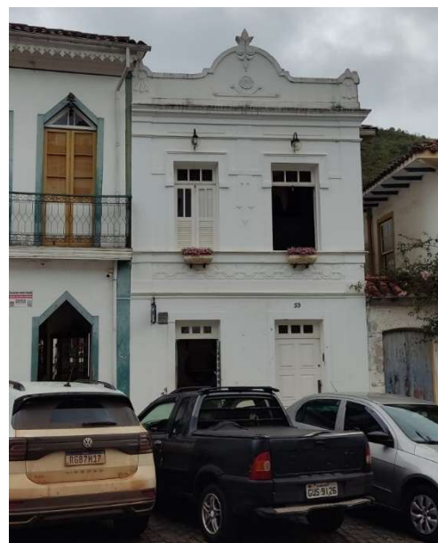
Figura 36- Vista em perspectiva da fachada do edifício EC7, ano 2024.
