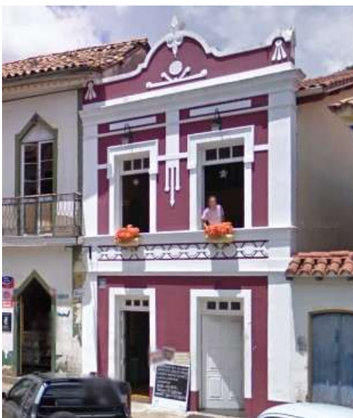
Figura 37- Vista em perspectiva da fachada do edifício EC7, ano 2009.
