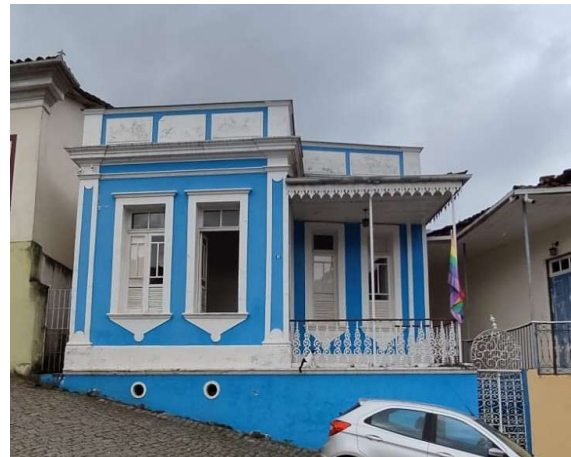
Figura 34- Vista em perspectiva da fachada do edifício EC6, ano 2024.
