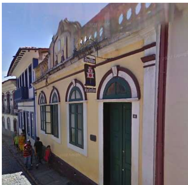
Figura 39- Vista em perspectiva da fachada do edifício EC8, ano 2009.
