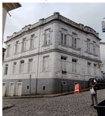
Figura 24- Vista em perspectiva da fachada do edifício EC1, ano 2024.
