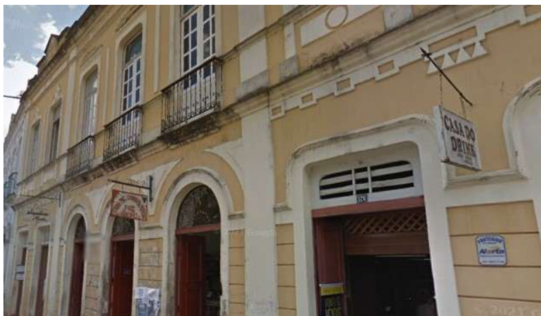
Figura 27- Vista em perspectiva da fachada do edifício EC2, ano 2009.
