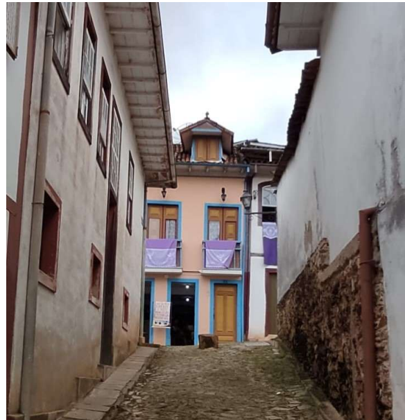
Figura 42- Vista parcial em perspectiva do edifício da rua Antônio de Albuquerque para o seu entorno.
