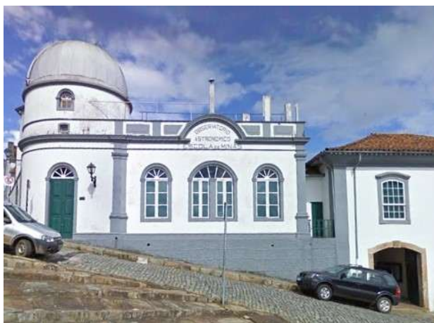
Figura 10 - Vista da fachada do edifício PC3, ano 2009.
