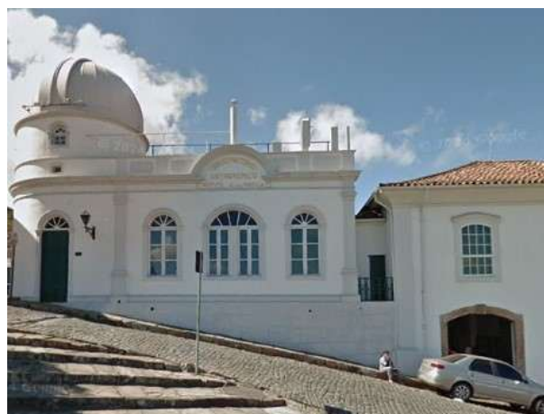
Figura 11 - Vista da fachada do edifício PC3, ano 2012.
