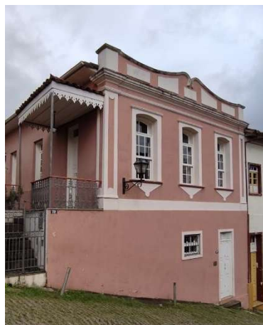
Figura 33- Vista em perspectiva da fachada do edifício EC5, ano 2024.
