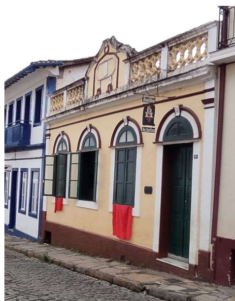
Figura 38- Vista em perspectiva da fachada do edifício EC8, ano 2024.
