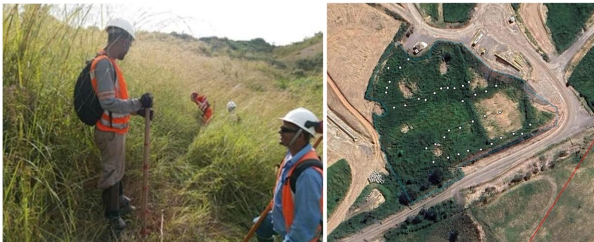
Figuras 55 e 56 – Mapeamento da instalação dos poços-teste e execução
