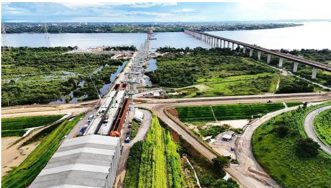
Figura 19 – Ilustra o avanço das obras da nova ponte sobre o Rio Tocantins, em Marabá-PA, em 11/03/2025
