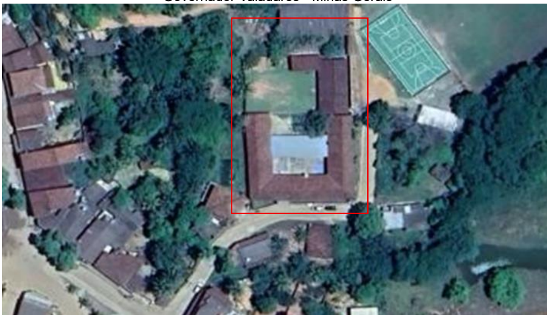
Figura 4 – Vista aérea da Escola Estadual Antônio Job da Cruz, no distrito de Vila Nova Floresta, Governador Valadares - Minas Gerais
