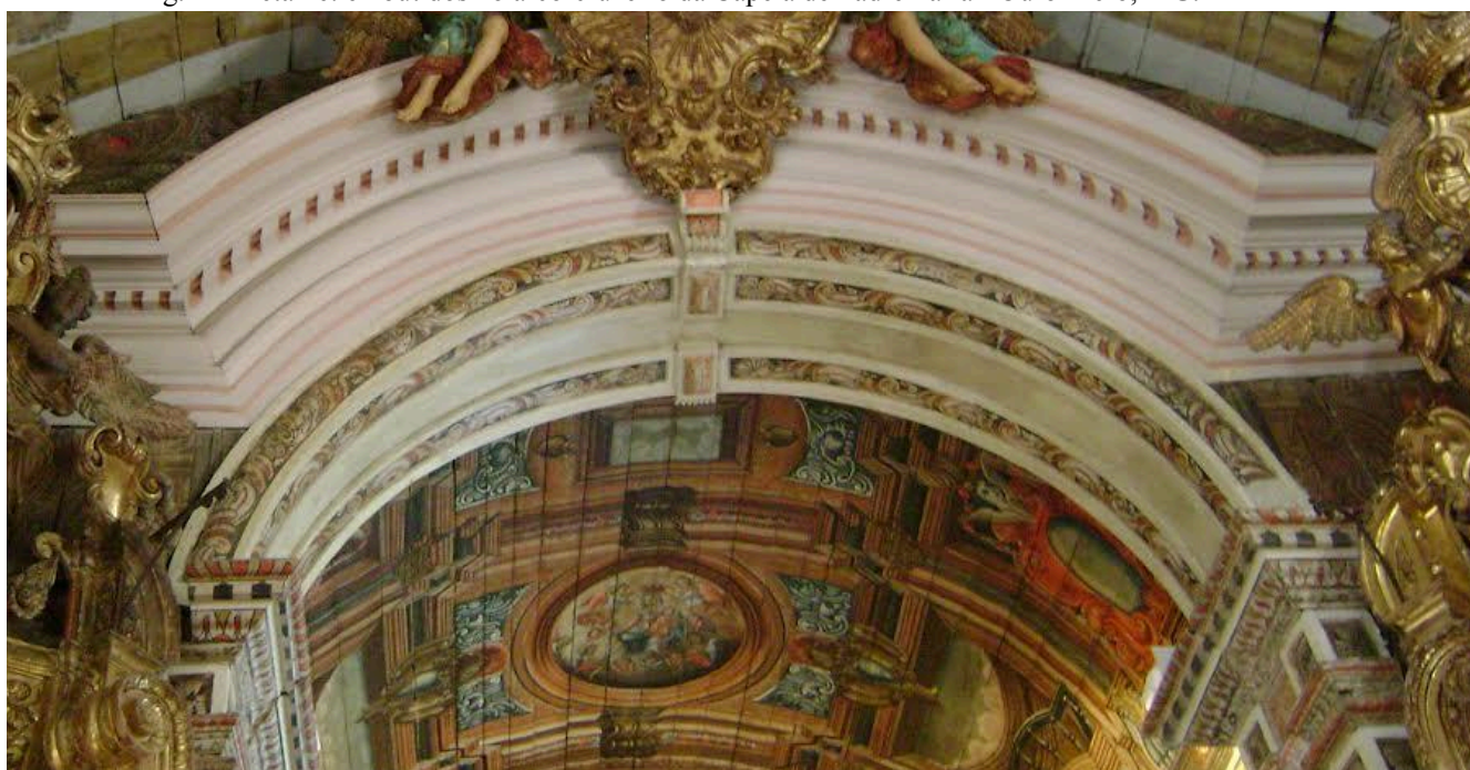
Fig. 11- Detalhe: embutidos no arco-cruzeiro da Capela de Padre Faria - Ouro Preto, MG.
