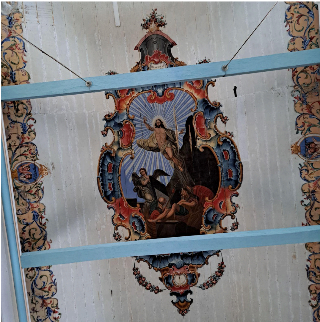
Fig. 2- Forro Igreja de Sant'Ana - Santana dos Montes, MG.
