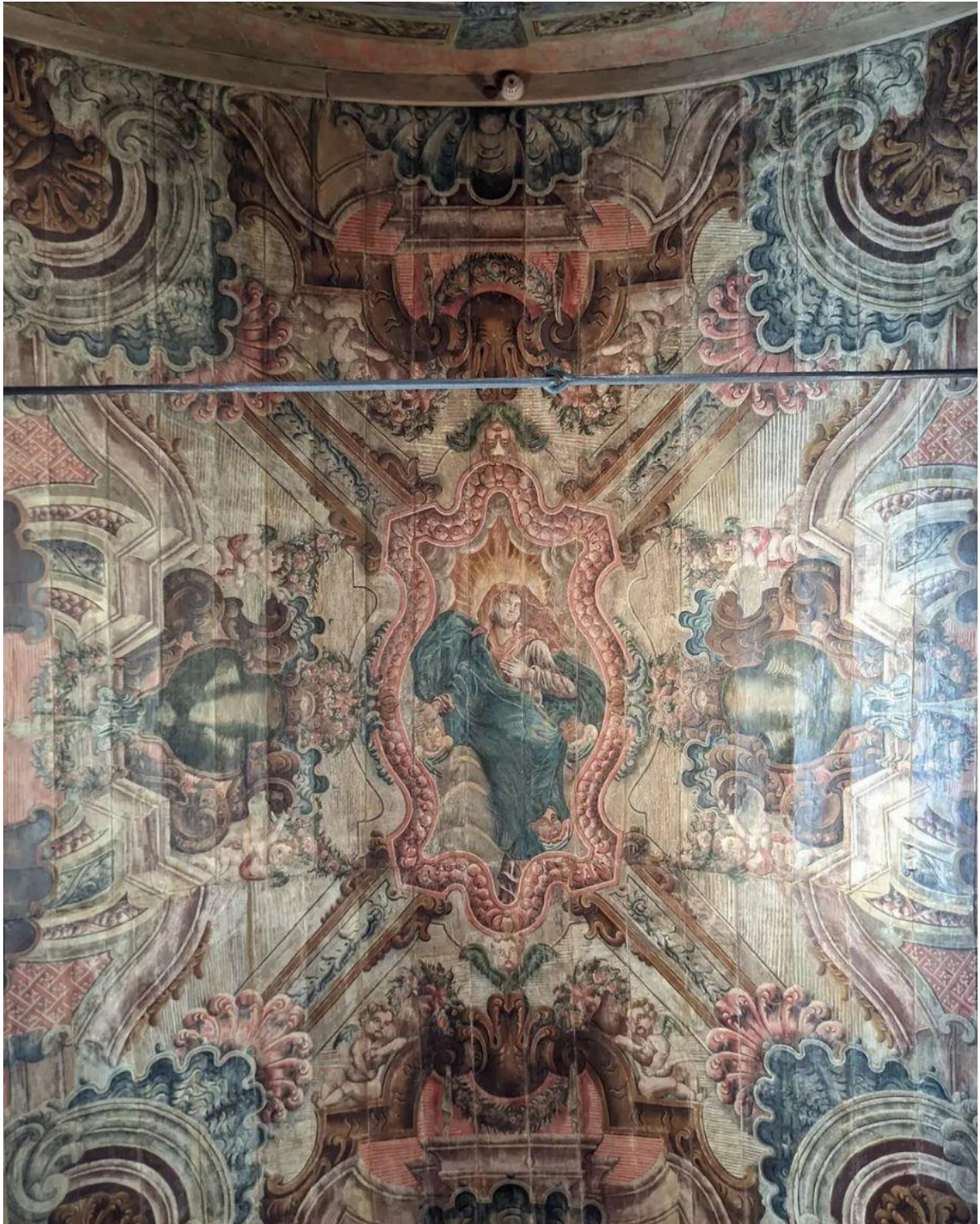
Fig. 30 - Igreja de Nossa Senhora Aparecida - Córregos, MG.
