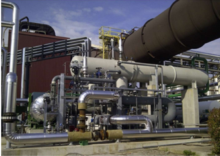
Figura 15 – ORC de 900 kW para siderúrgica (Exergy).
