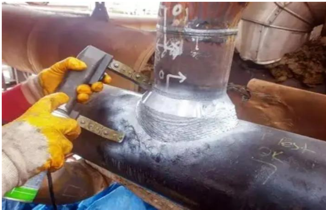
Figura 12 – Ensaio PM em união soldada de tubulação
