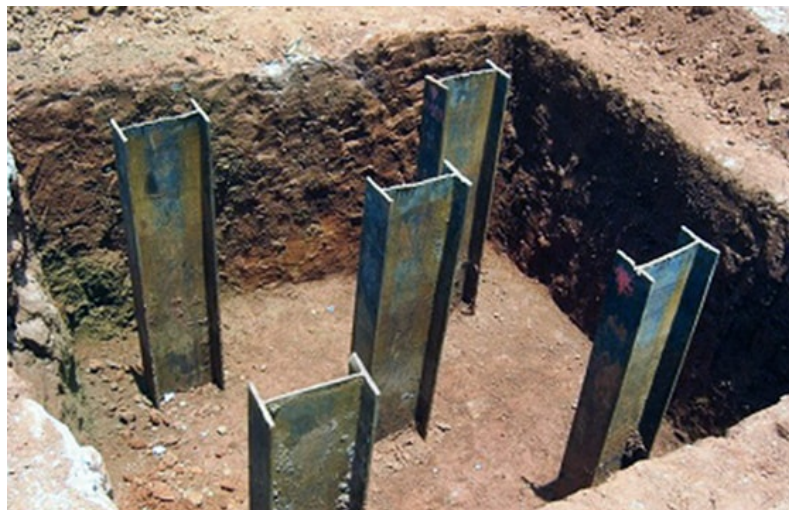
Figura 36 – Estacas pré-moldadas de aço
