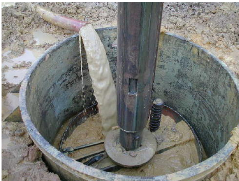
Figura 32 – Lama bentonítica sendo utilizada na perfuração de um estacão
