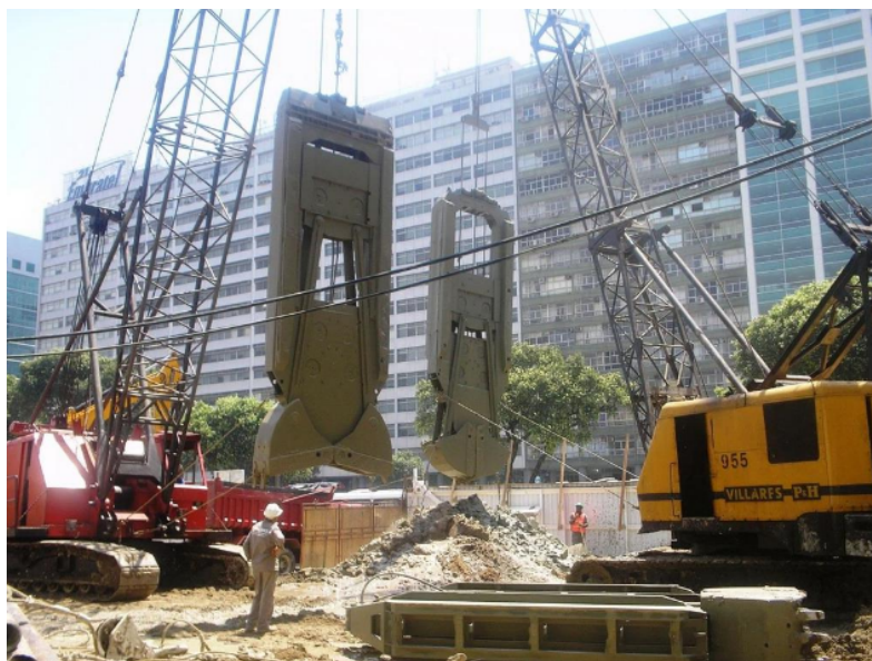
Figura 31 – Clam shell acoplado a guindastes
