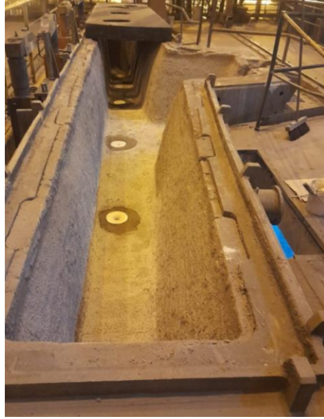
Figura 4 – Distribuidor em preparação dos refratários
