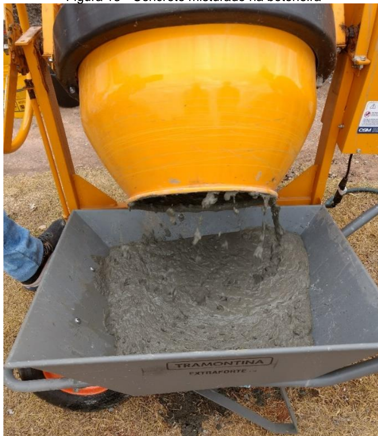
Figura 13 - Concreto misturado na betoneira
