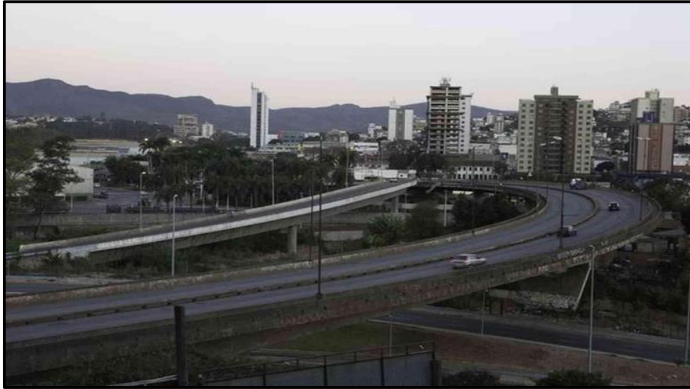
Figura 15 - Viaduto Engenheiro Andrade Pinto
