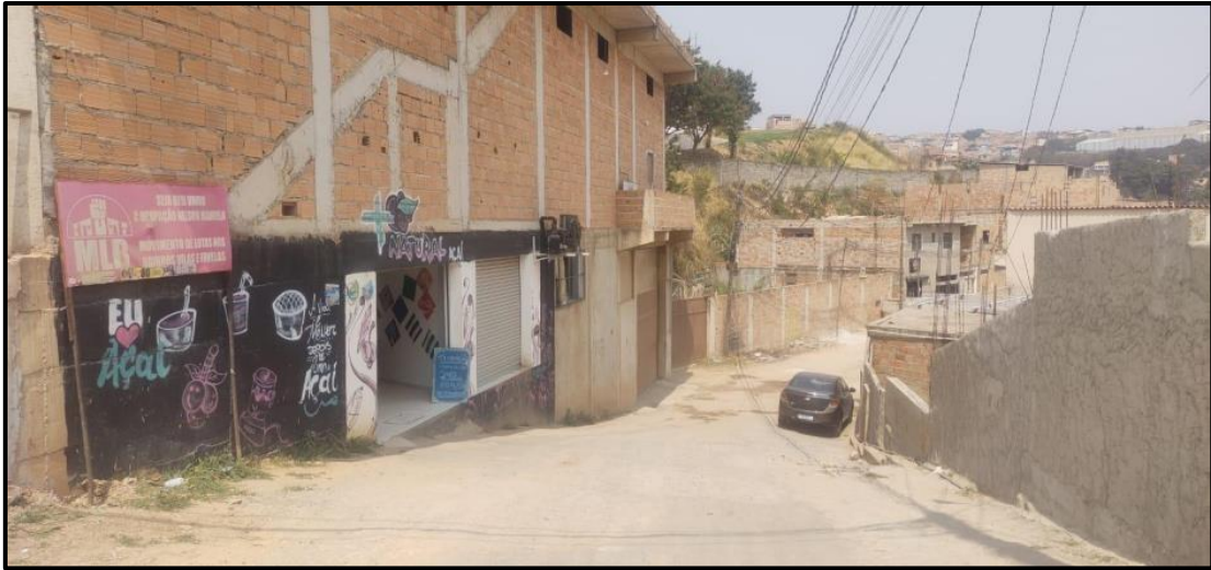
Figura 1 - Entrada da ocupação Nelson Mandela
