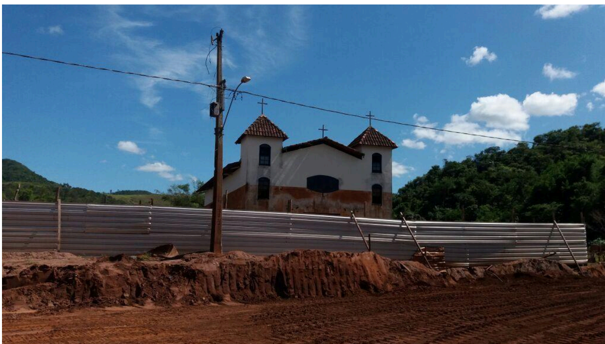
Figura 15 - Igreja Santo Antônio, Paracatu de Baixo, após o rompimento da barragem
